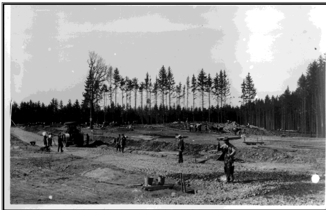
XII. 17. Úprava dvora Vranč určeného k výstavbě nové obce Bítov 23
