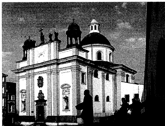
21. Děčín, děkanský kostel sv. Kříže, pohled od jihozápadu, současný stav.
