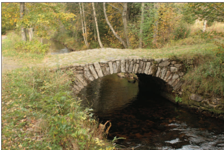
Obr. 18: Most přes kanál (říjen 2009).
