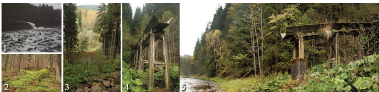
Obr. 16: Skluz do Křemelné. 1 – skluz ve 30. letech 20. století (Běl 1998, 20), 2 – skluz v betonovém potrubí v prudkém svahu, 3 – pohled na dřevěné zakončení skluzu, 4 – dřevěná rampa, 5 – dřevěná rampa a Křemelná (říjen 2009).
