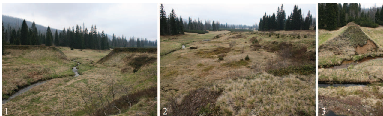
Obr. 13: Bývalá Luzenská nádrž na Břežníku. 1 – průlom v hrázi, 2 – prostor nádrže, 3 – profil hráze v detailu (foto: Hedvika Zahálková, květen 2010).
