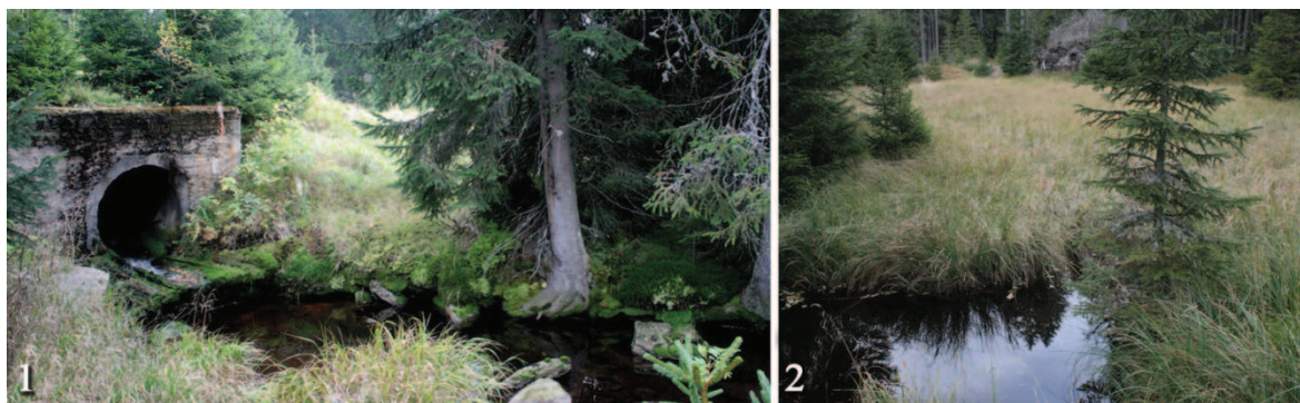
Obr. 11: Hráz (1) a prostor bývalé Černohorské nádrže (2) (říjen 2009).
