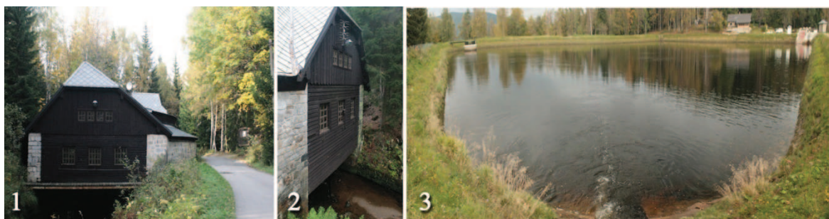
Obr. 34: 1, 2 – vtokový objekt elektrárny Vydra, 3 – vyrovnávací nádrž elektrárny Vydra, (říjen 2009).
