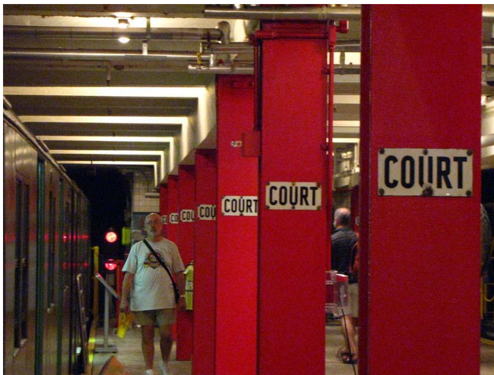
Obr. 19 – Nástupiště stanice Court, dnes muzeum městské hromadné dopravy, New York, listopad 2010. Dodnes je v amerických městech, např. New Yorku či Chicagu, dodržován koncept dobré viditelnosti identifikace stanice. Při zastavení ve stanici prakticky nemáte možnost přehlédnout název místa, kde se v danou chvíli nacházíte.
