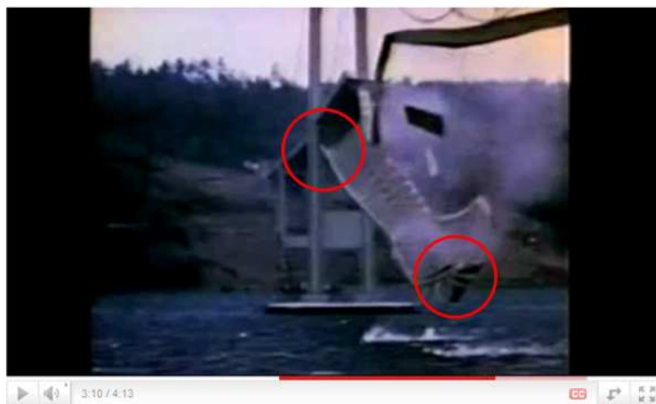
obr. č. 4.21: destrukce mostu Tacoma – pozastavení a označení detailů [64]
