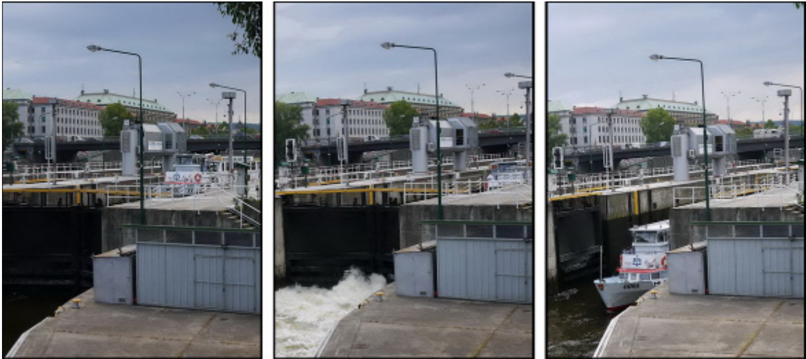
Obr. 7: Postupné klesání vody v plavební komoře
