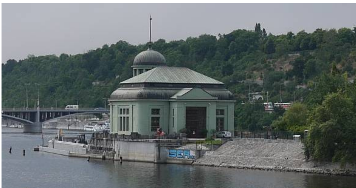
Obr. 2: Vodní elektrárna na Štvanici
