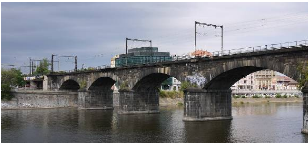
Obr. 5: Část Negrelliho viaduktu
