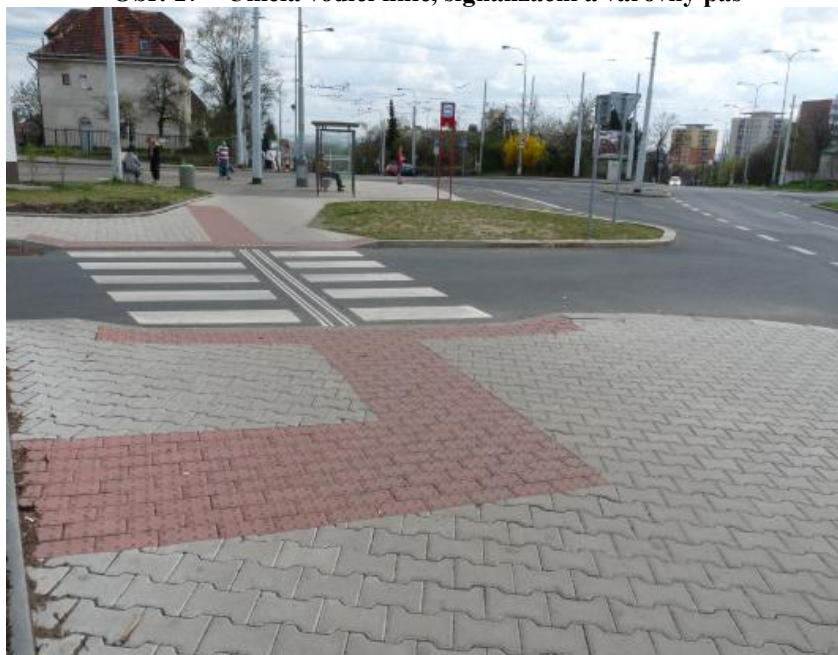
Obr. 17 – Umělá vodící linie, signalizační a varovný pás
