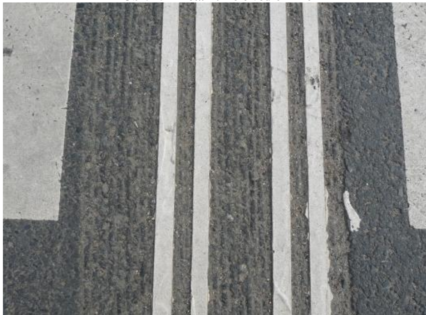
Obr. 15 – Detail umělé vodící linie
