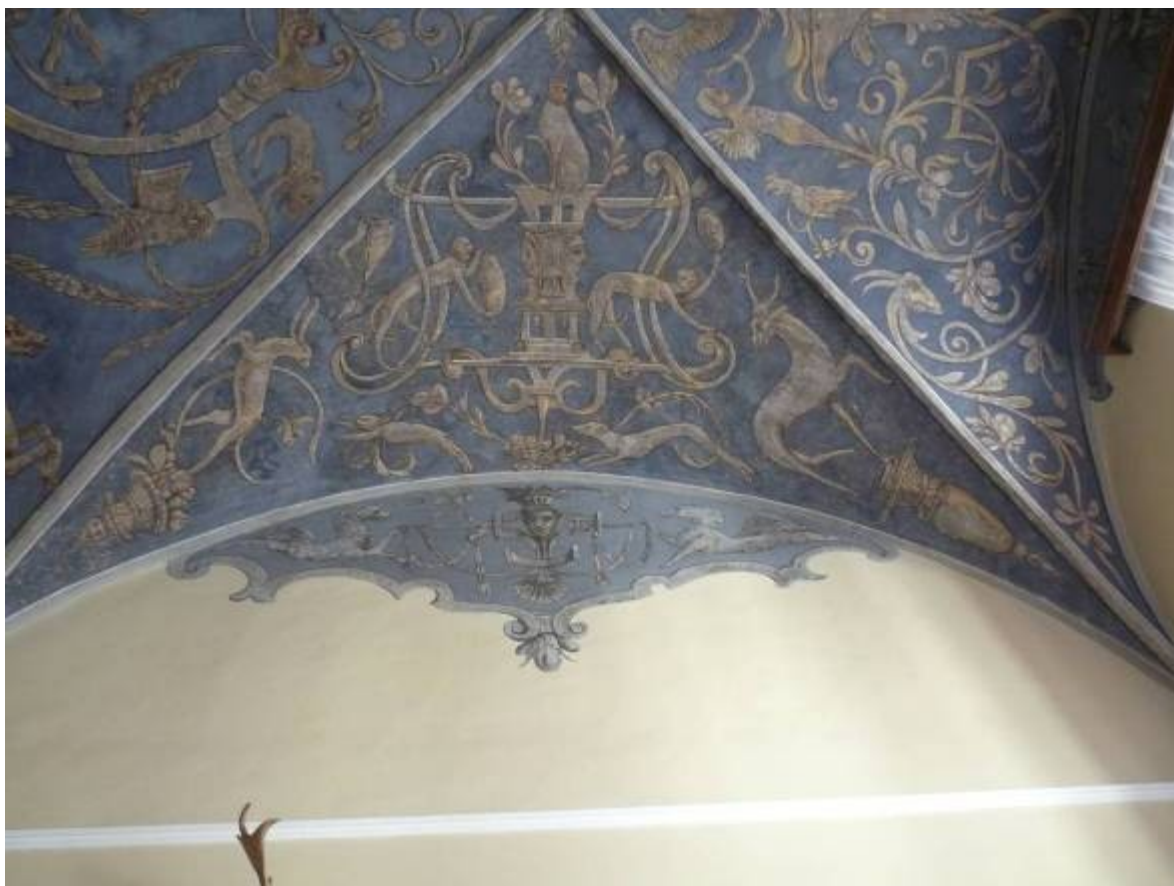
86. Grottesková malba, východní klenební kápě, místnost v 1. patře severního paláce
