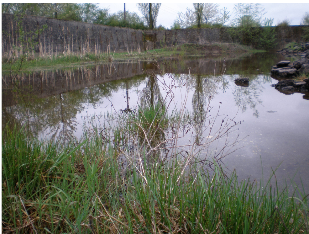
Obr. 6: Příklad celobetonové nádrže. Lokalita Jenišovice – silážní jáma.
