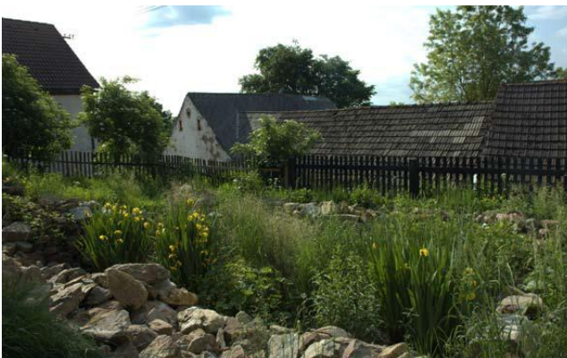
Obr. 19 KČOV u soukromého objektu na Šumavě (foto Michal Šperling)
