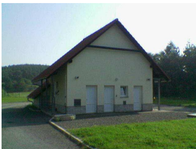
Obr. 22 ČOV v obci Višňová na Příbramsku
