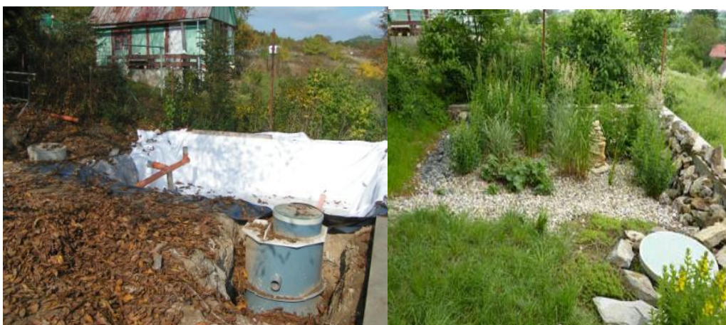
Obr. 20 Rozestavěná KČOV u rodinného domu v Mnichovicích (vlevo), stejná čistírna po roce provozu (vpravo), (foto Adam Krejčík)
