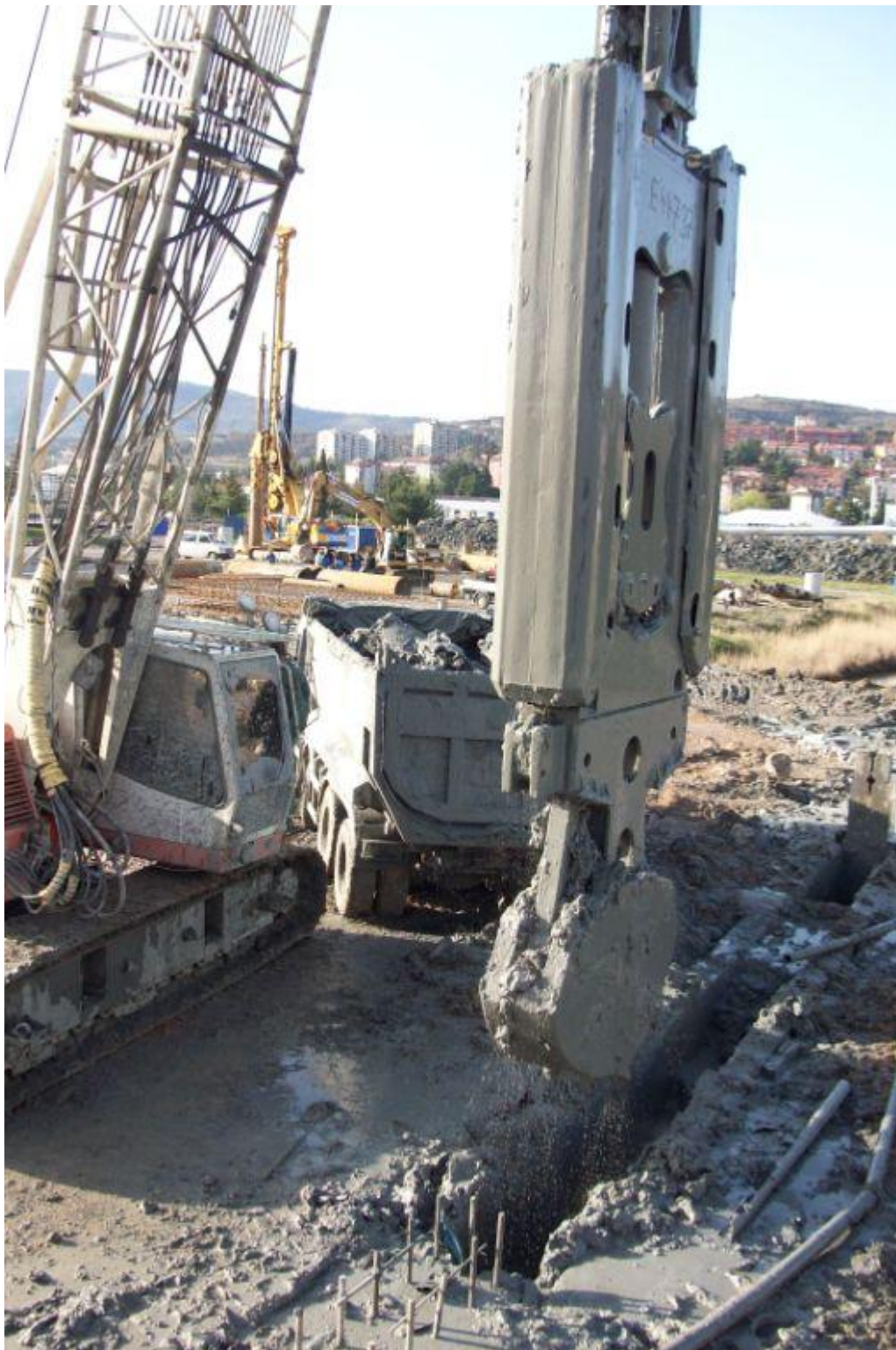
Obr. 16 Těžba zeminy drapákem při tvorbě lamel podzemní stěny (foto Zakládání group a. s.)
