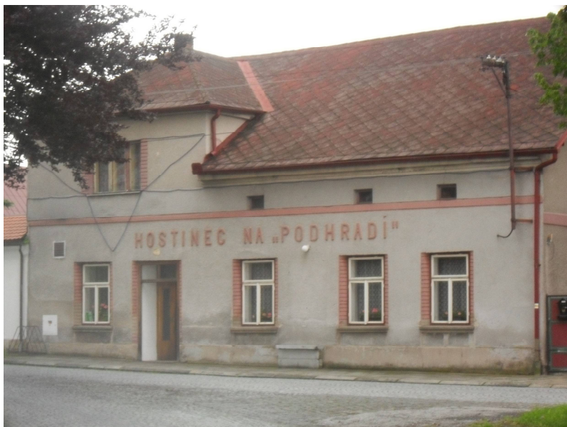
Foto 5: Hostinec ve Velkém Vřešťově (objekt, který doporučuji k rekonstrukci a zavedení celodenní otevírací doby včetně vaření jídel, viz kap.7.2) Foto:K. Turek
