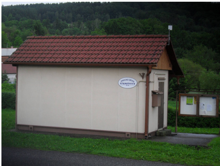
Foto 1: Obecní úřad v obci Stanovice (lze vidět, že obecní úřad může být i ve stavební buňce). Foto: K. Turek
