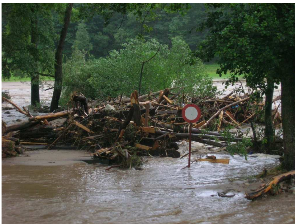
Obr. 79 Průběh povodně 2009, naakumulovaný materiál u mostu. Foto: Kotál 2009
