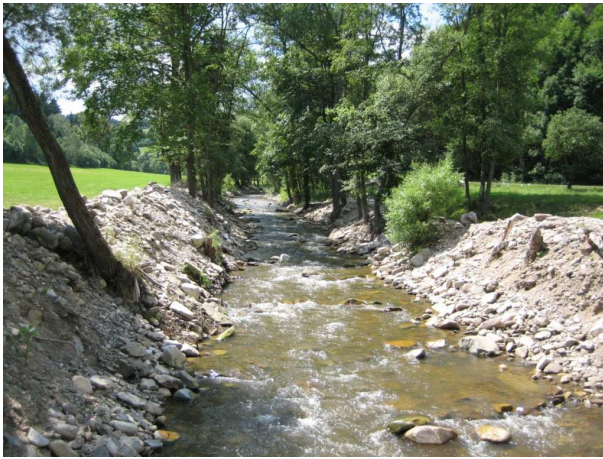
Obr. 60 Příklad zkapacitněného koryta na toku Volyňka u Sudslavic.
