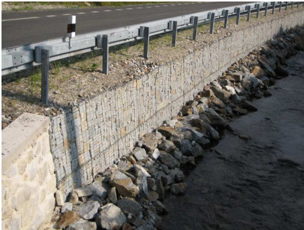
Obr. 14 Příklad gabionu. Foto: Z. Rettichová, 2010
