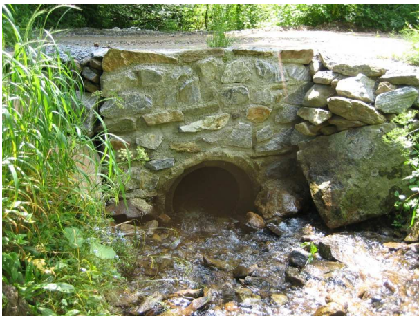
Obr. 69 Nově vytvořený propustek, Foto: Z. Rettichová, 2010
