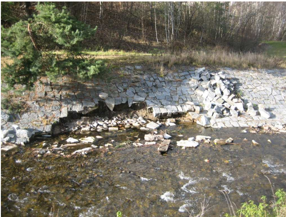
Obr. 83 Příklad poškození regulace po povodni 2009 ve Vimperku. Foto: Z. Rettichová, 2009
