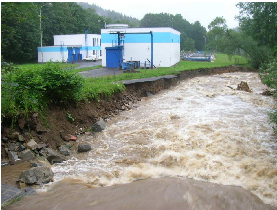
Obr. 80 Průběh povodně 2009 u ČOV, jeden z kritických úseků. Foto: Kotál, 2009
