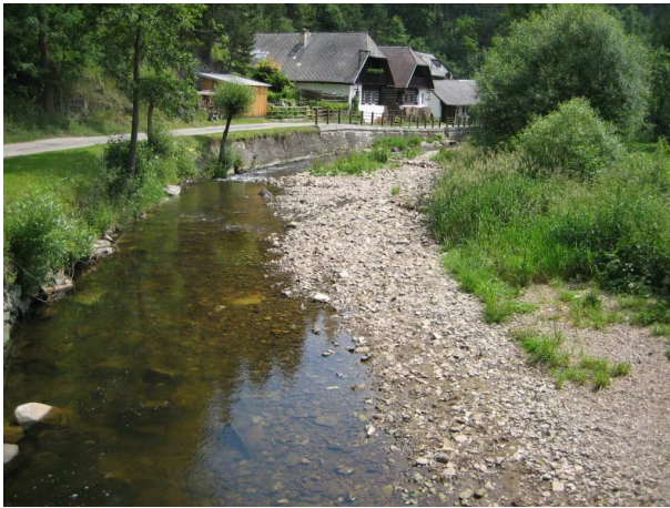
Obr. 31 Příklad korytové akumulace na toku Spůlka.
