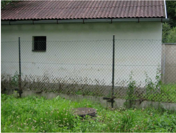
Obr. 22 Příklad hlubokého rozlivu v příbřežní zóně, na plotu jsou patrné náplavy s výškou nad 1 m. Foto: Z. Rettichová, 2009
