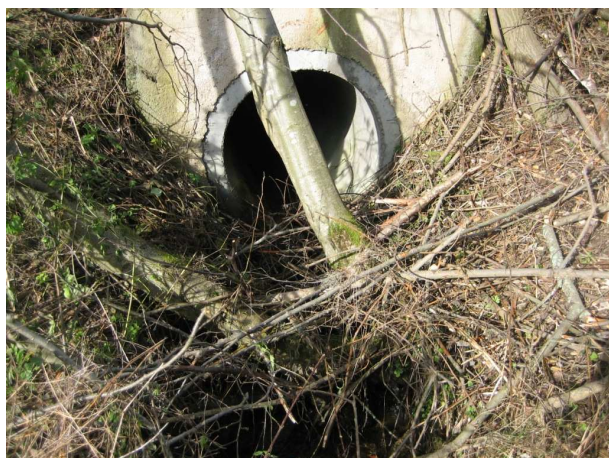
Obr. 63 Příklad propustku na Jilmovém potoce. Foto: Z. Rettichová, 2009
