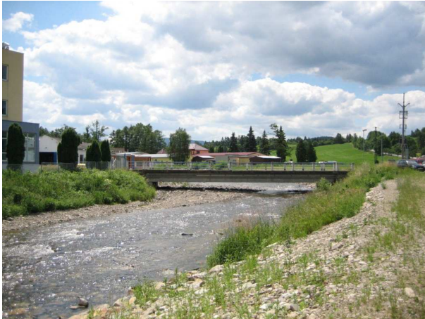
Obr. 26 Příklad potenciální překážky v proudění, nevhodně dimenzovaný most v Bohumilicích. Foto: Z. Rettichová, 2009
