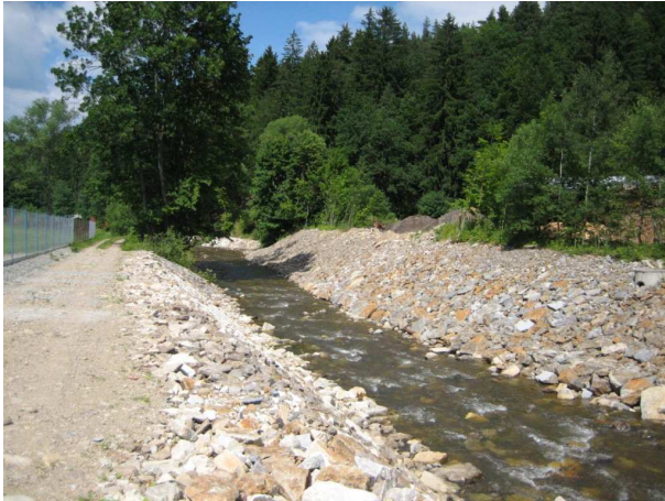
Obr. 29 Úprava koryta a dna, zpevnění kamenným pohozením, během povodně dochází k urychlení povodňové vlny. Foto: Z. Rettichová, 2010
