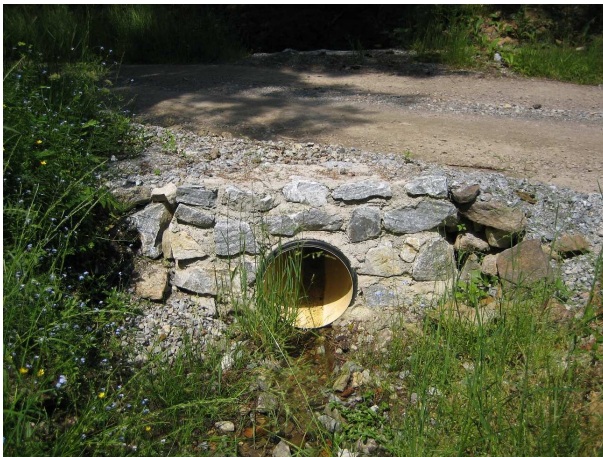
Obr. 9 Příklad propustku. Foto: Z. Rettichová, 2009
