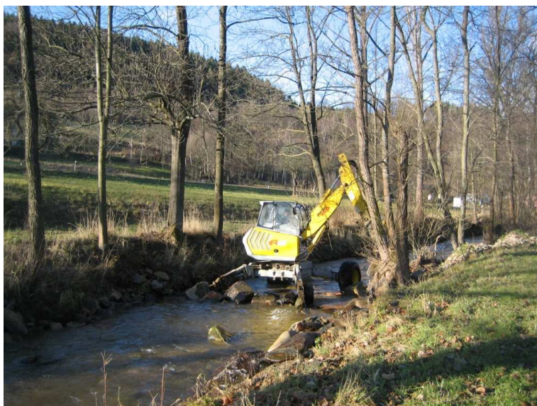
Obr. 76 Úprava koryta a břehu po povodni 2009. Foto: Z. Rettichová, 2009
