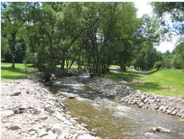
Obr. 15 Příklad kamenného pohozu na Volyňce, velká část koryta je takto upravována. Foto: Z. Rettichová, 2010
