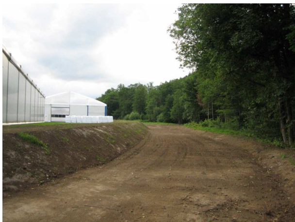
Obr. 19 Příklad nově vybudovaného protipovodňového valu u Čkyně.
