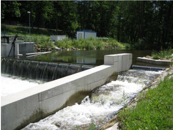
Obr. 8 Příklad jezu s rybím přechodem v Bohumilicích.
