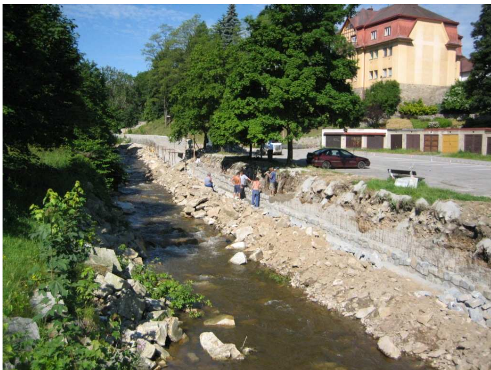
Obr. 87 Stavba nové protipovodňové hráze ve Vimperku. Foto: Z. Rettichová, 2010
