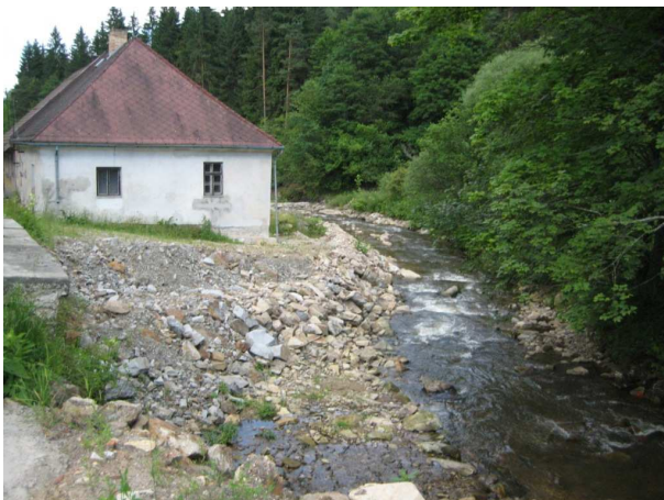
Obr. 27 Příklad nevhodného umístění budovy v inundačním území.
