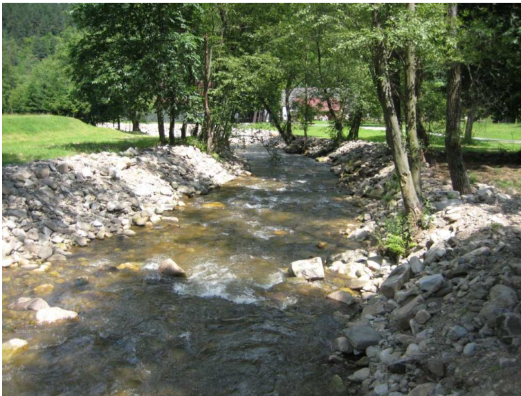
Obr. 77 Zkapacitněné koryto a břehy upravené kamenným pohozem.
