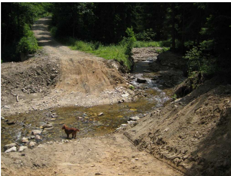
Obr. 70 Nově vytvořené koryto na Pravětínském potoce. Foto: Z. Rettichová, 2010
