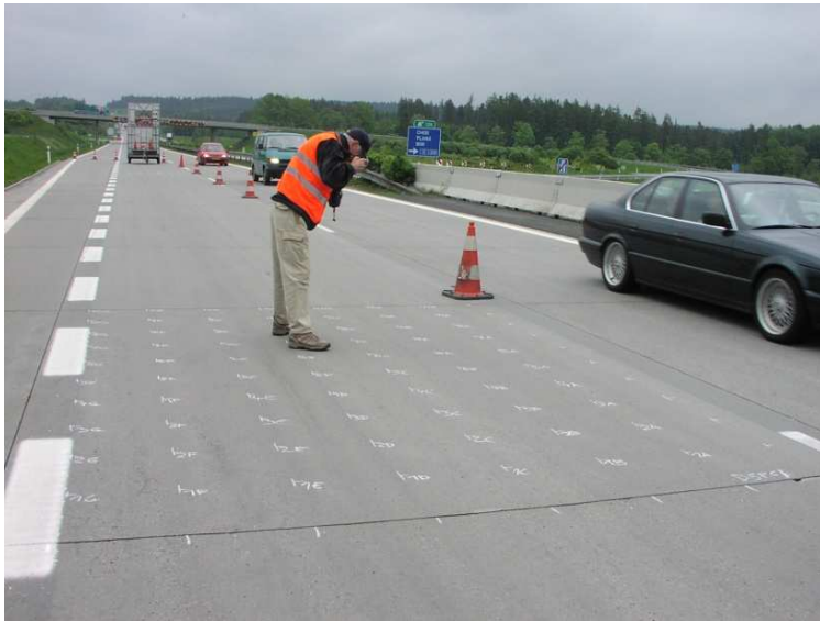
Obr. 4. Fotodokumentace CBK (dálnice D5 - 128,23. km směr Rozvadov; deska D5PC; 21.5.2008).
