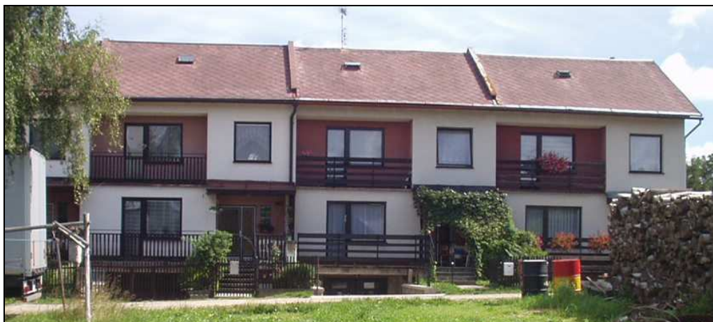
Foto. 1: Proměny tradiční zástavby v obci Křižánky (místní část Mor. Křižánky)
