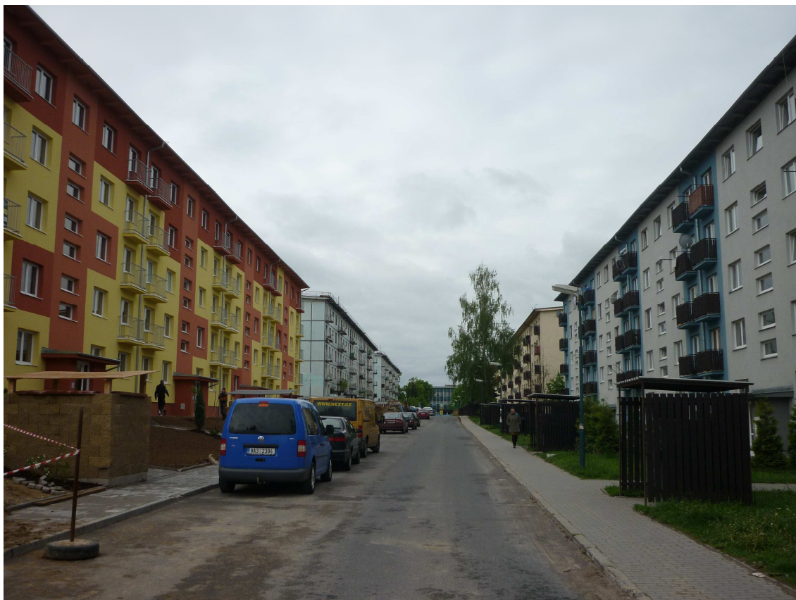
Foto: Vlastní, pořízeno dne 15. 5. 2010. Postupující rekonstrukce tzv. kyjeváků, postavených Sověty převážně v 70. letech 20. století.
