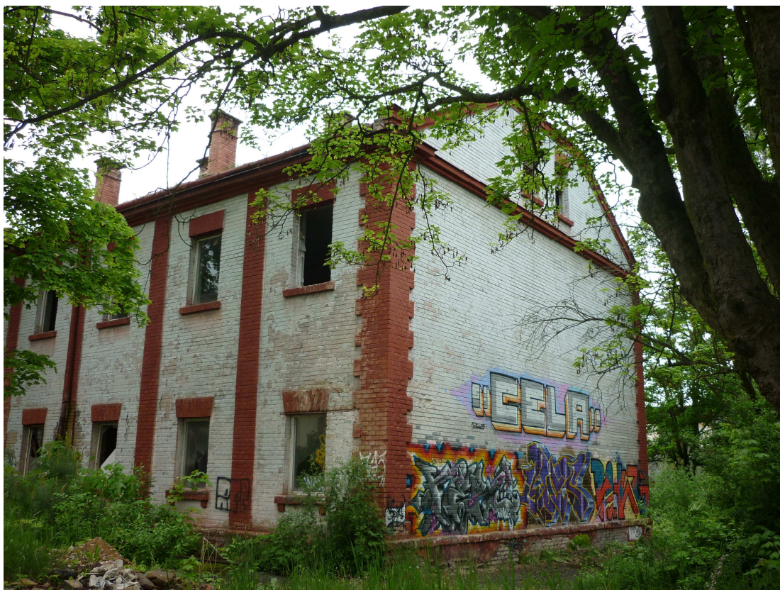
Foto: Vlastní, pořízeno dne 15. 5. 2010. Dosud nerekonstruovaná budova bývalého rakouského tábora.
