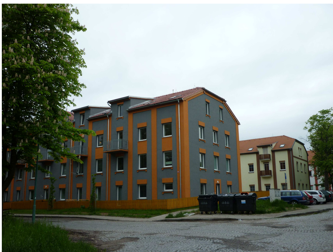
Foto: Vlastní, pořízeno dne 15. 5. 2010. Opravené budovy bývalého rakouského tábora.
