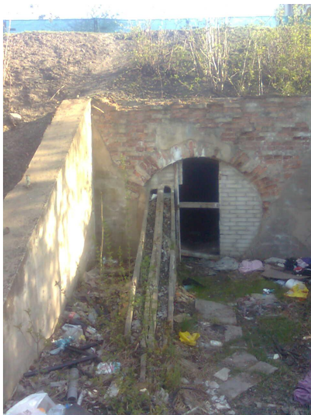
Obrázek .6. Provizorní obydlí Praha Vyso any. B ezen 2010
