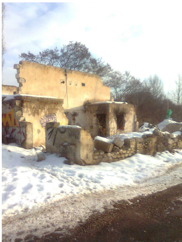
Obrázek .4. Provizorní šobydlíõ v Praze 9 ó Hloub tín. Prosinec 2009.
