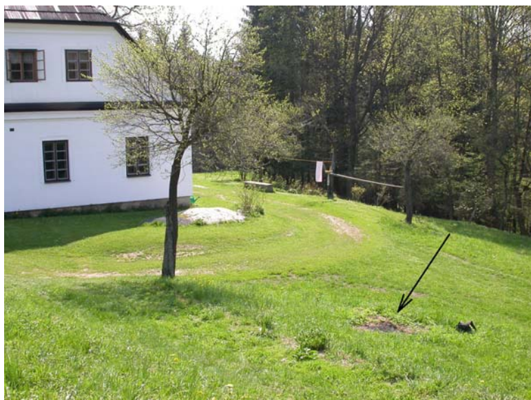
Obr. 41. Zасыpaný propad (místo označeno šipkou) z roku 2001 západně od domu č. 86 v Jesenném. Foto D. Velebil
