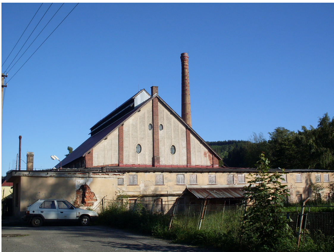
Budova bývalé sklárny v Josefově Dole, v současné době mimo provoz.
