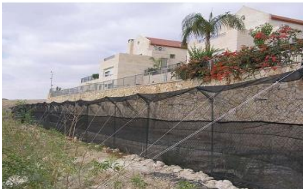
Obr. 2: Bariéra umístěná pod ulicí Sheizaf v Ma'ale Adumin (Izrael) je tvořena vzájemně se překrývajícími 150 cm širokými pruhy (převzato z Faiman a kol. 2009).
