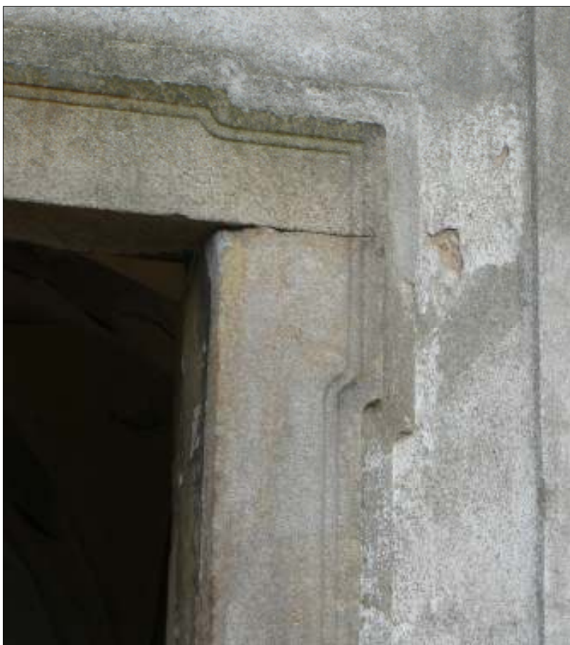
30. Detail ostění portálu, západní průčelí, foto 2009
