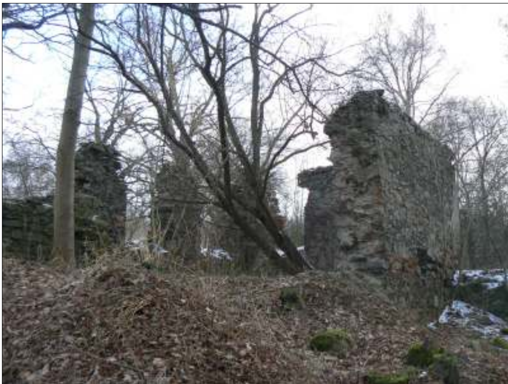
36. Torzo bývalé márnice, foto 2009
