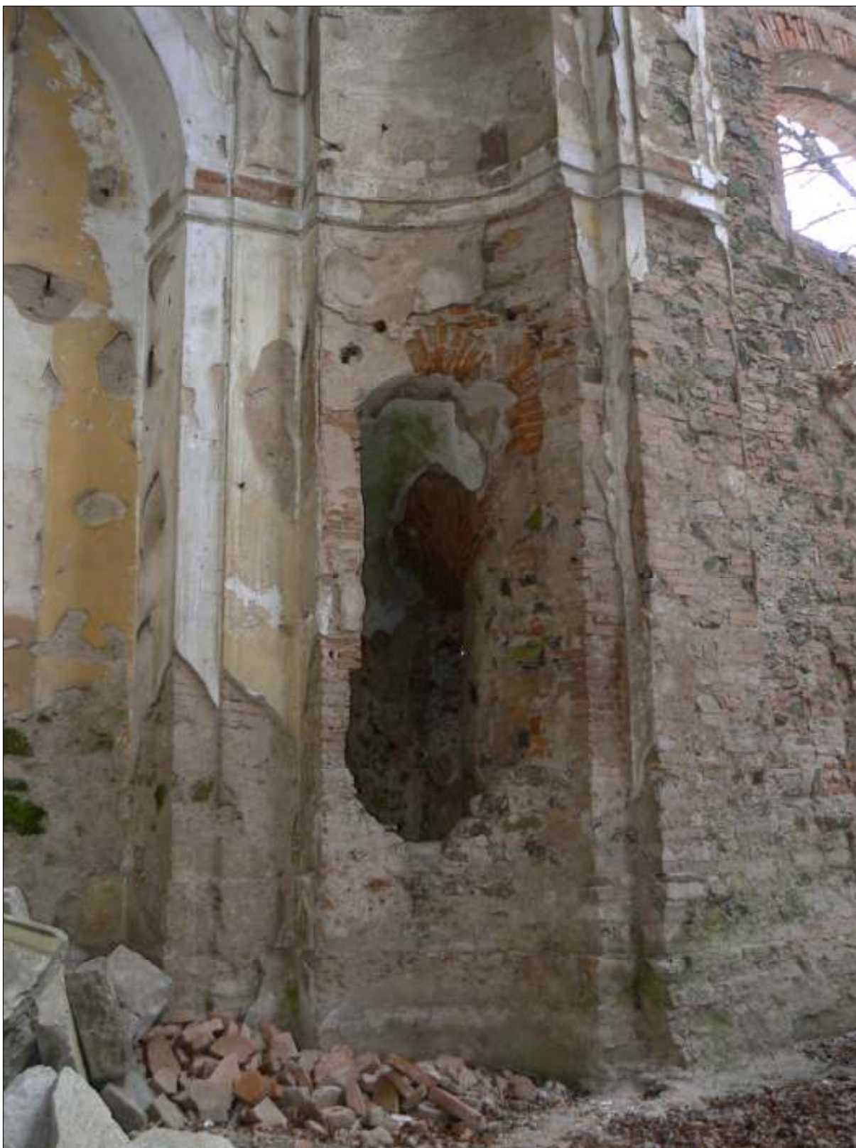
24. Vyústění vstupu na kazatelnu v severní stěně lodi, foto 2009
