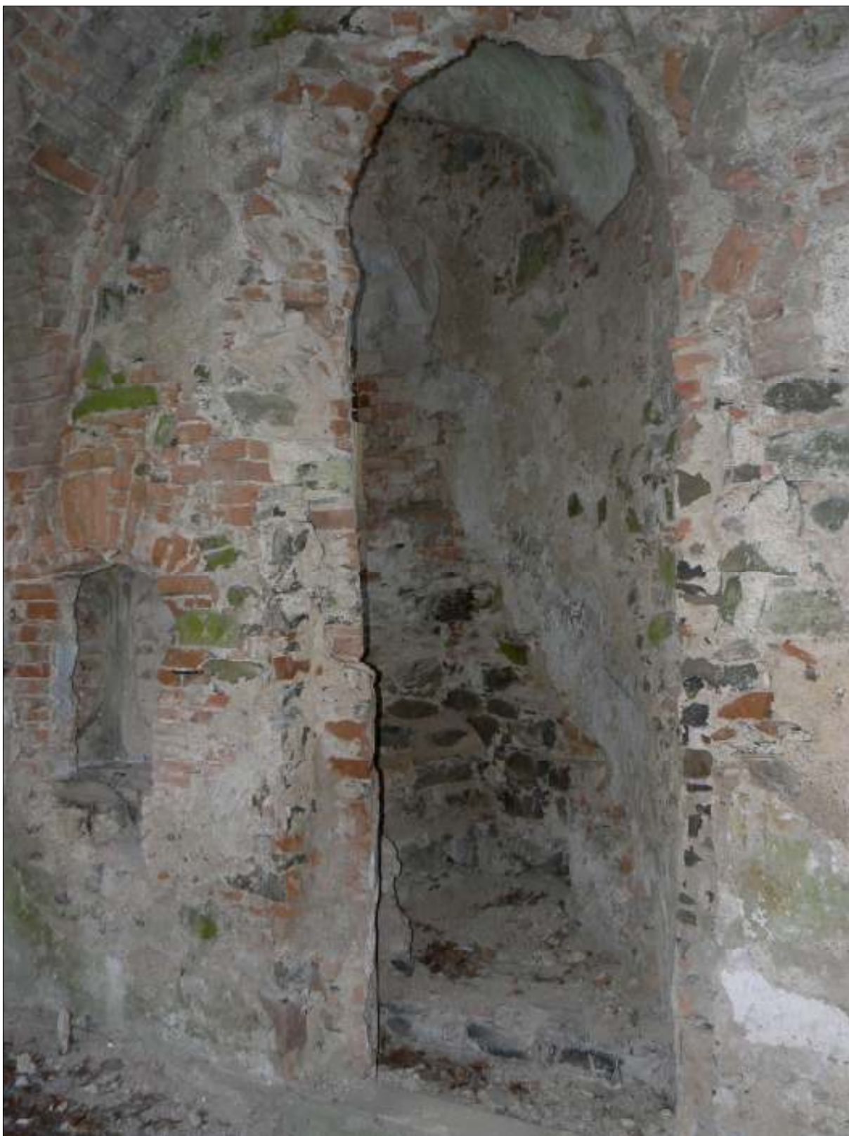
23. Pohled na zbytky schodiště, vedoucího z severní sakristie na kazatelnu, foto 2009
