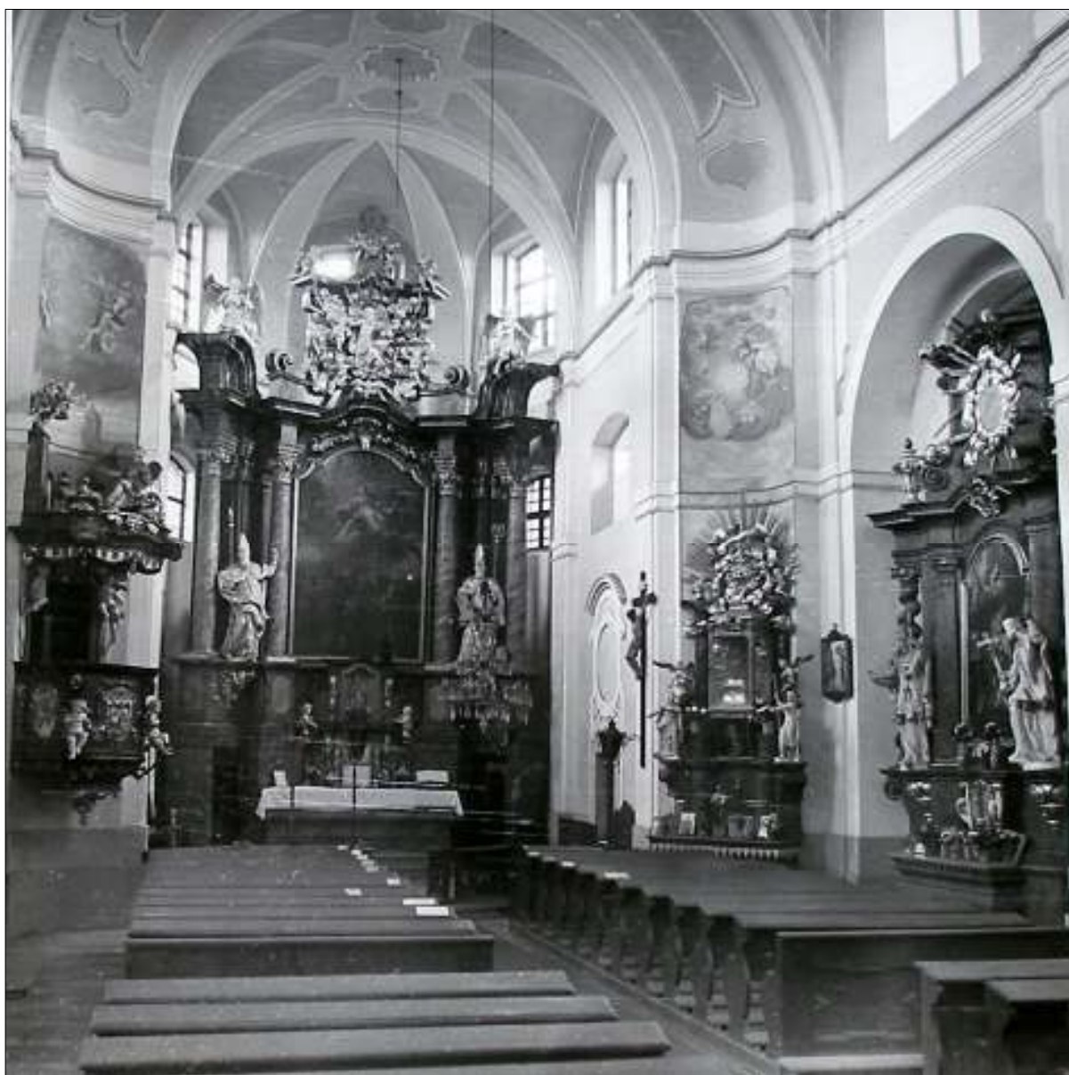
14. Pohled do lodi směrem k hlavnímu oltáři, foto ve farní kronice, 1951
