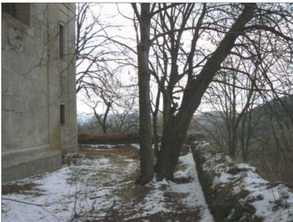
34. Pohled na tarasní zeď tvořící areál bývalého hřbitova, foto 2009
