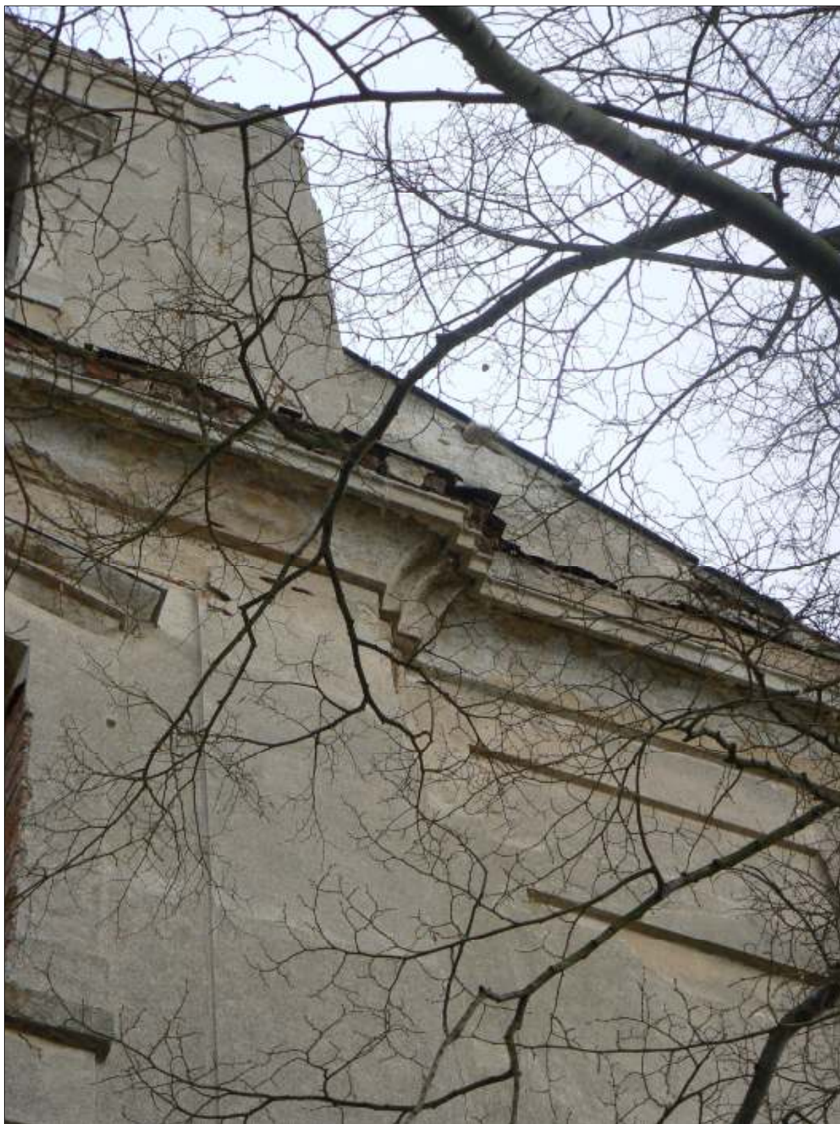
32. Detail korunní římsy, západní průčelí, foto 2009
