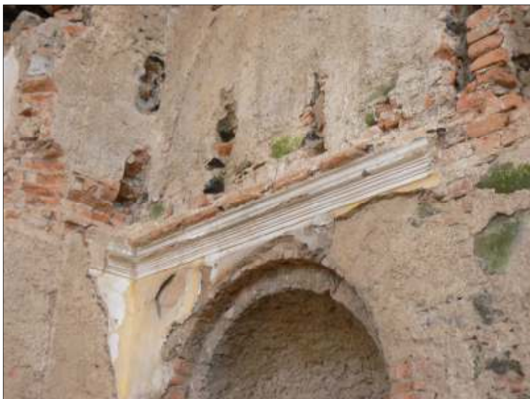
26. Detail římsy nad bývalou zpovědnicí, foto 2009
