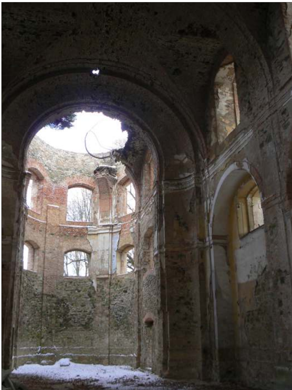
21. Pohled do presbytáře kostela, foto 2009, levá část dozdivána v nedávné době
