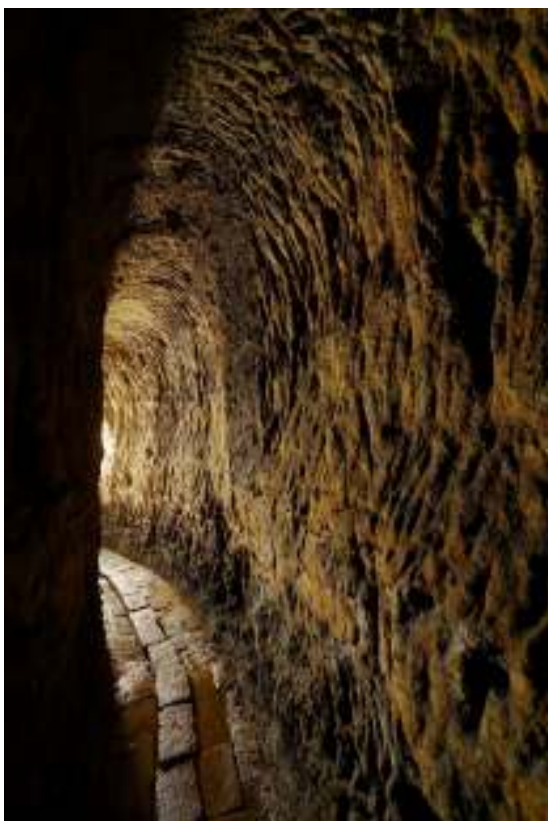
Obrázek 46: Velká zahradi štola Strahovského kláštera. Foto: MM
