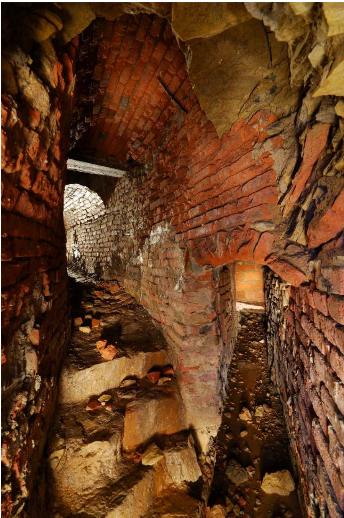
Obrázek 26: Štola č. 2 s odvodňovací stružkou chrání základy konventní budovy a knihovního křídla vpravo. Foto: M. Majer, Podzemní Praha, 2008.
