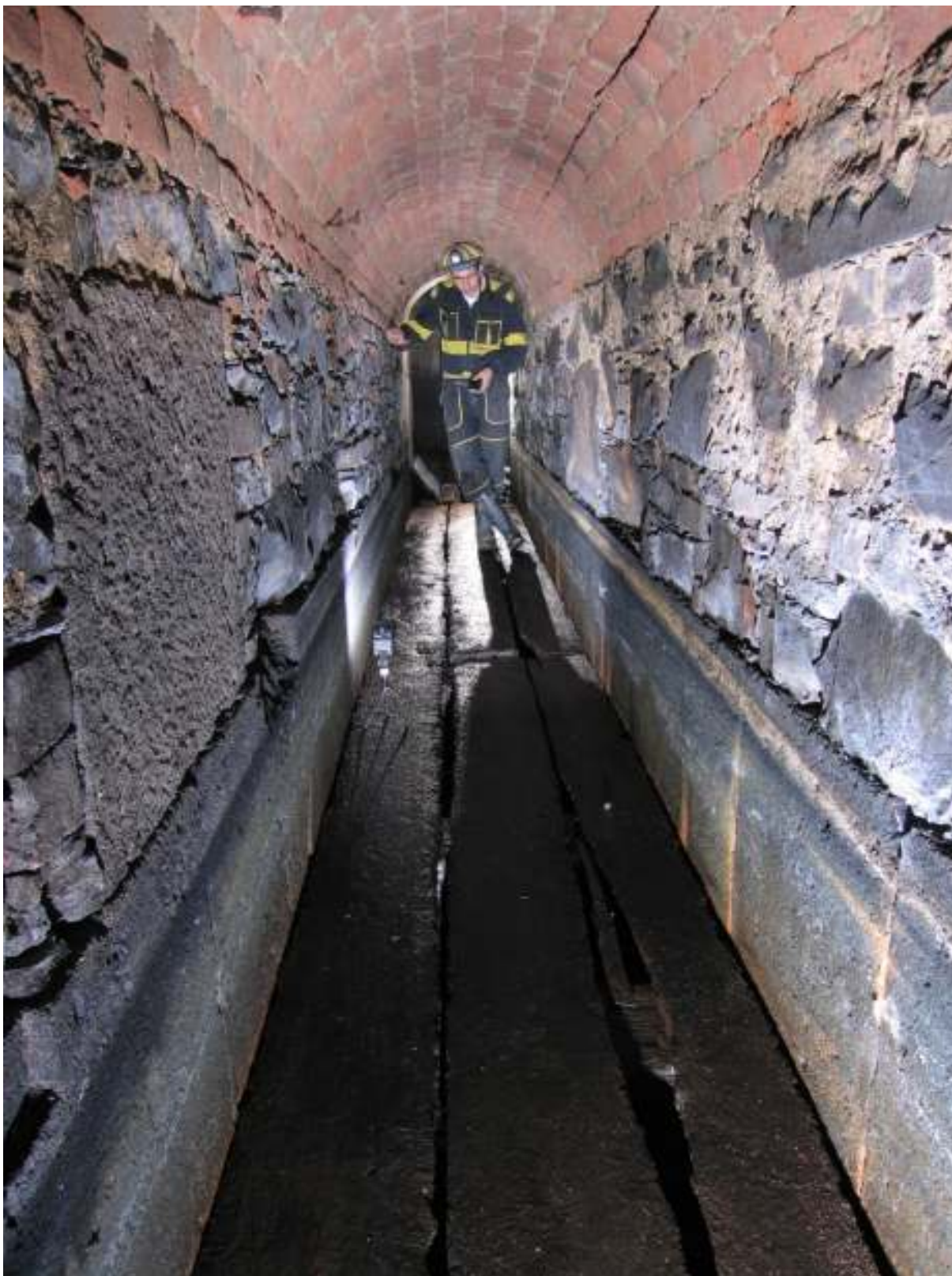
Obrázek 58: Modrá štola plaského kláštera. Na základovém roštu je položena prkenná podlaha přichycená dřevěnými kolíky. Smíšené zdivo je oddělené od pískovcových bloků ležících na základovém roštu břidlicovou izolací. Foto: JŘ.
