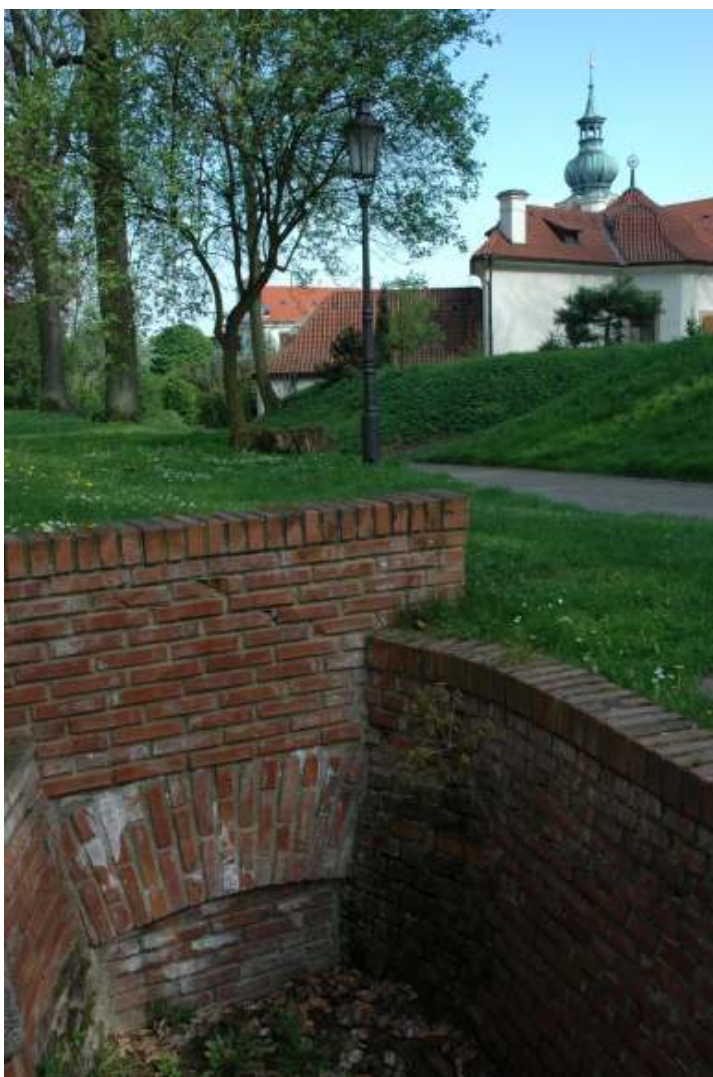
Obrázek 22: Zazděný portál štoly 1 před domkem zahradníka. Foto: PL
