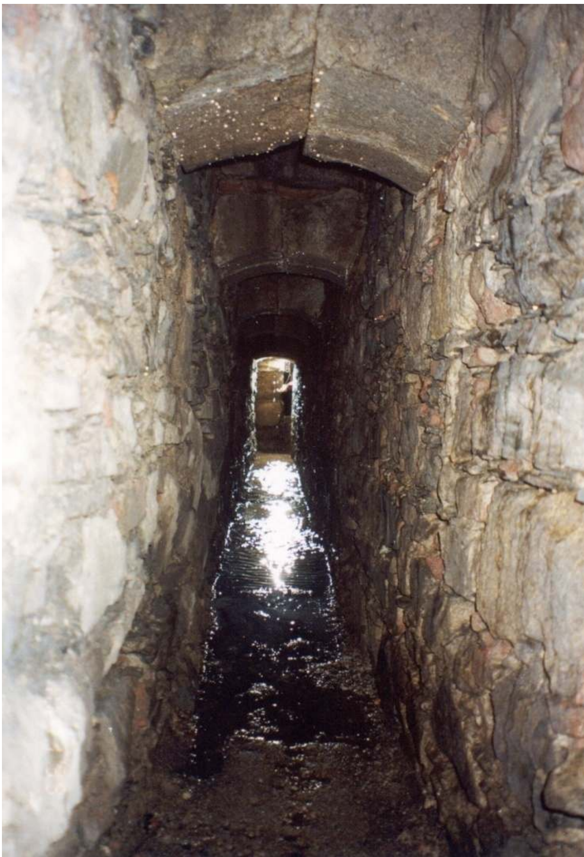
Obrázek 50: Pohled do větrací štoly. Foto: JŘ
