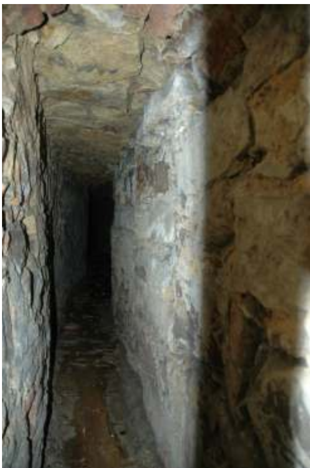
Obrázek 24: Odvodňovací štola č. 2, u vstupu ze suterénu kláštera. Foto: PL
