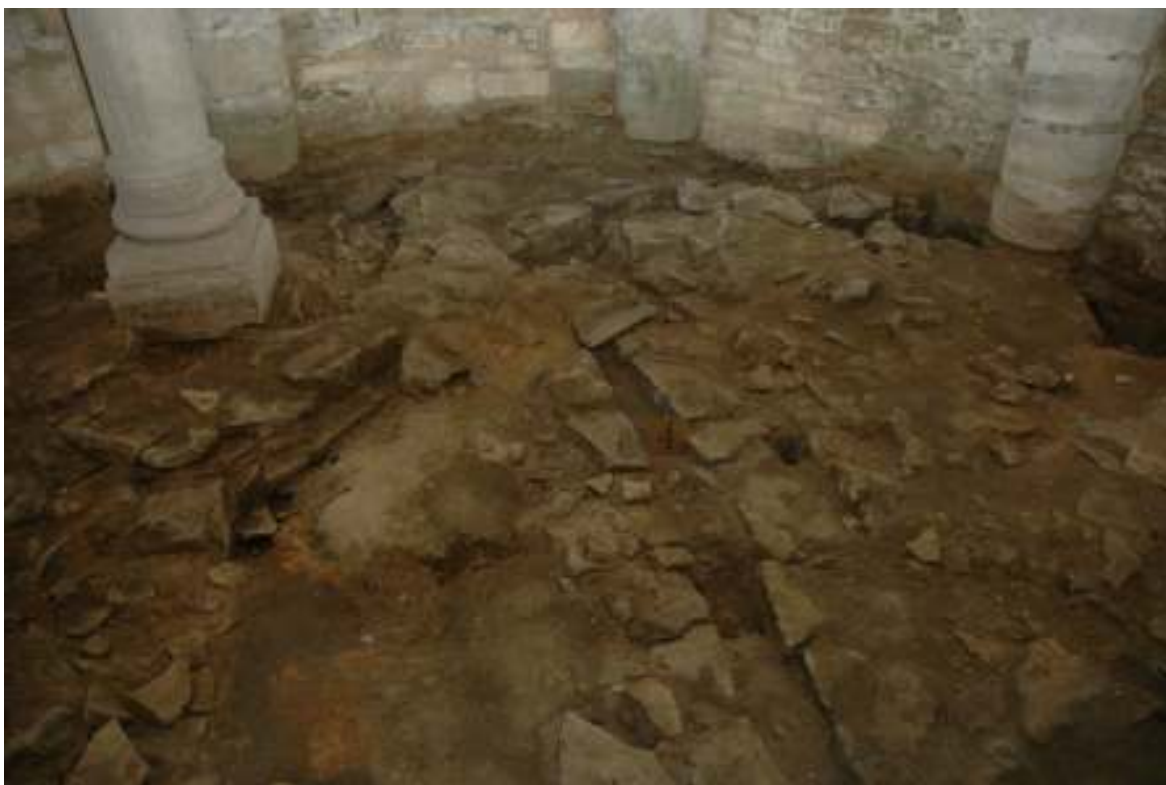
Obrázek 28: Podlaha románské krypty s odkrytými odvodňovacími kanálky. Foto: PL
