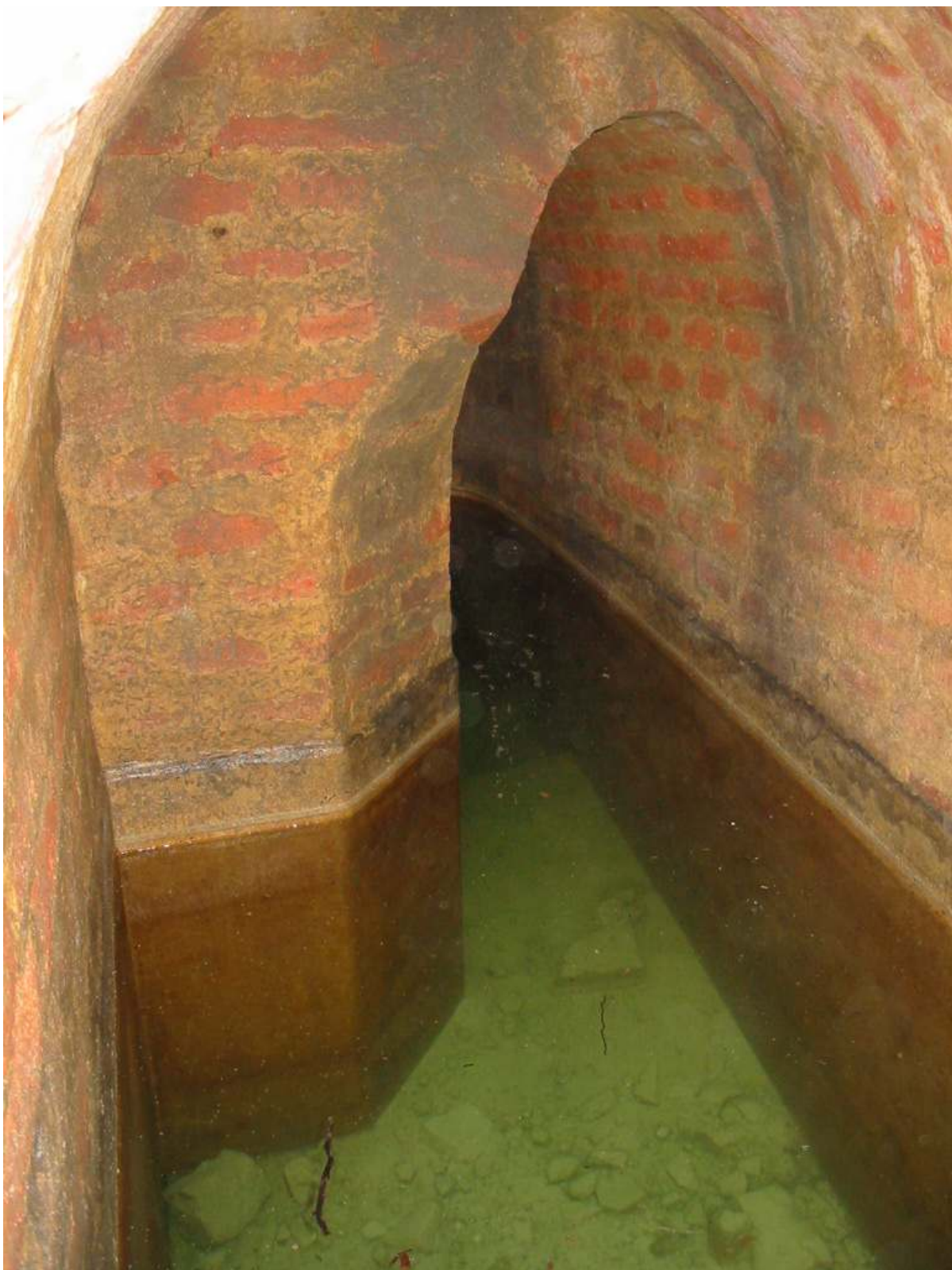
Obrázek 32: Cisterna pod východním křídlem Sartoriova konventu. Foto: JŘ
