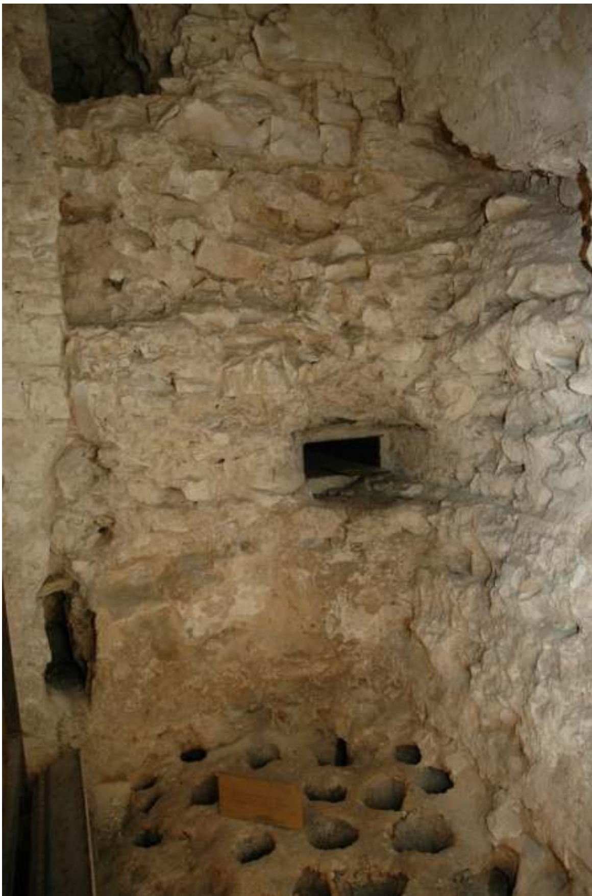
Obrázek 29: Provdušňovací kanály v kryptě. V podlaze otisky po dřevěných pilotách z doby dřevěné stavby v 11. století. Foto: PL
