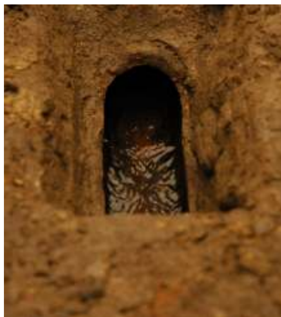
Obrázek 37 a 38: Revizní otvory v kameninovém vodovodním potrubí. Foto: PL
