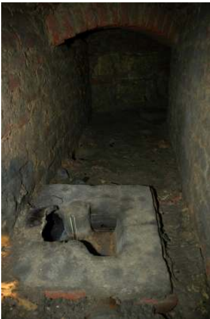
Obrázek 39: Hradítko ve vodovodní štole. Foto: PL
