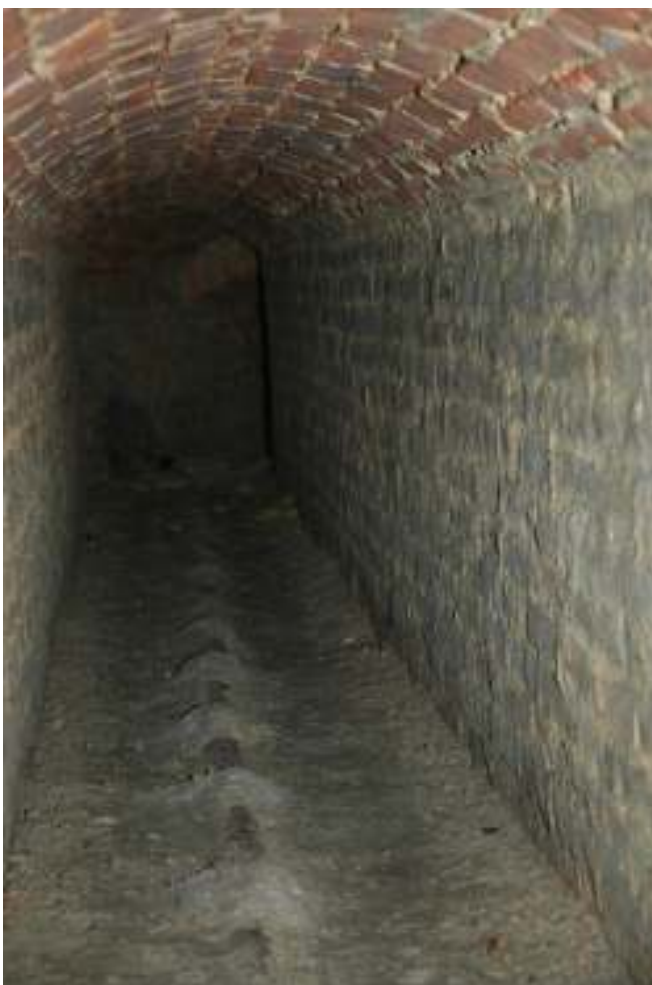
Obrázek 36: Kameninové potrubí na dně vodovodní štoly. Foto: PL
