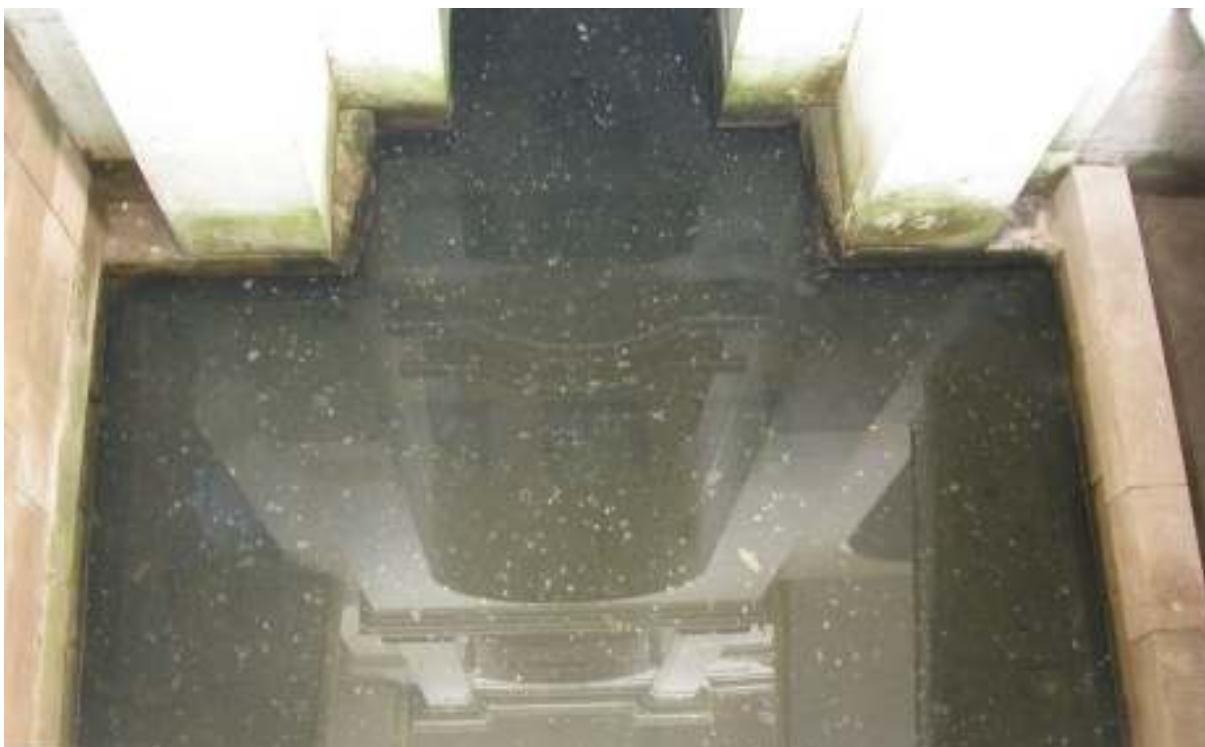
Obrázek 56: Jižní zrcadlo. Vodní bazén základového dubového roštu v jižním schodišti za normálního stavu s výškou hladiny 44 cm nad dnem hlavního kanálu. Foto: JŘ
