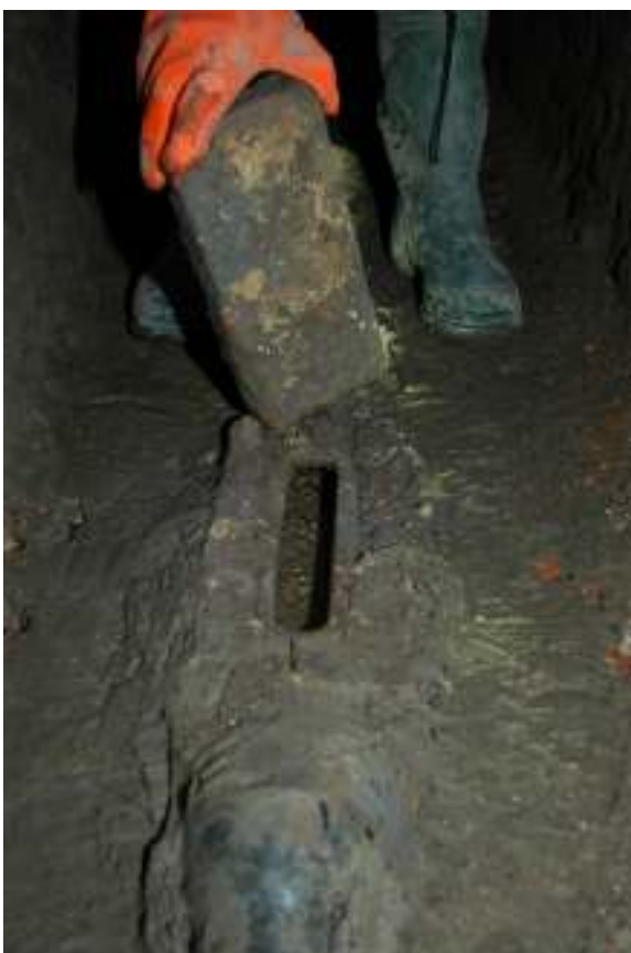
Obrázek 37 a 38: Revizní otvory v kameninovém vodovodním potrubí. Foto: PL
