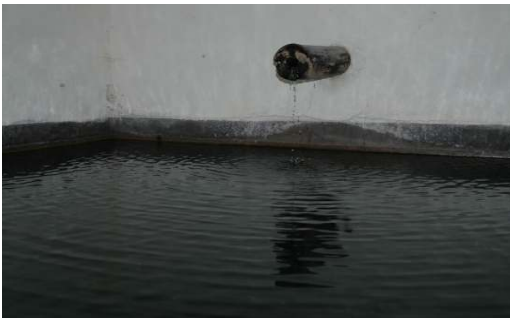
Obrázek 40: Bazén (lavatorium) v suterénu kláštera do něžž ústí vodovodní štola. Foto: PL
