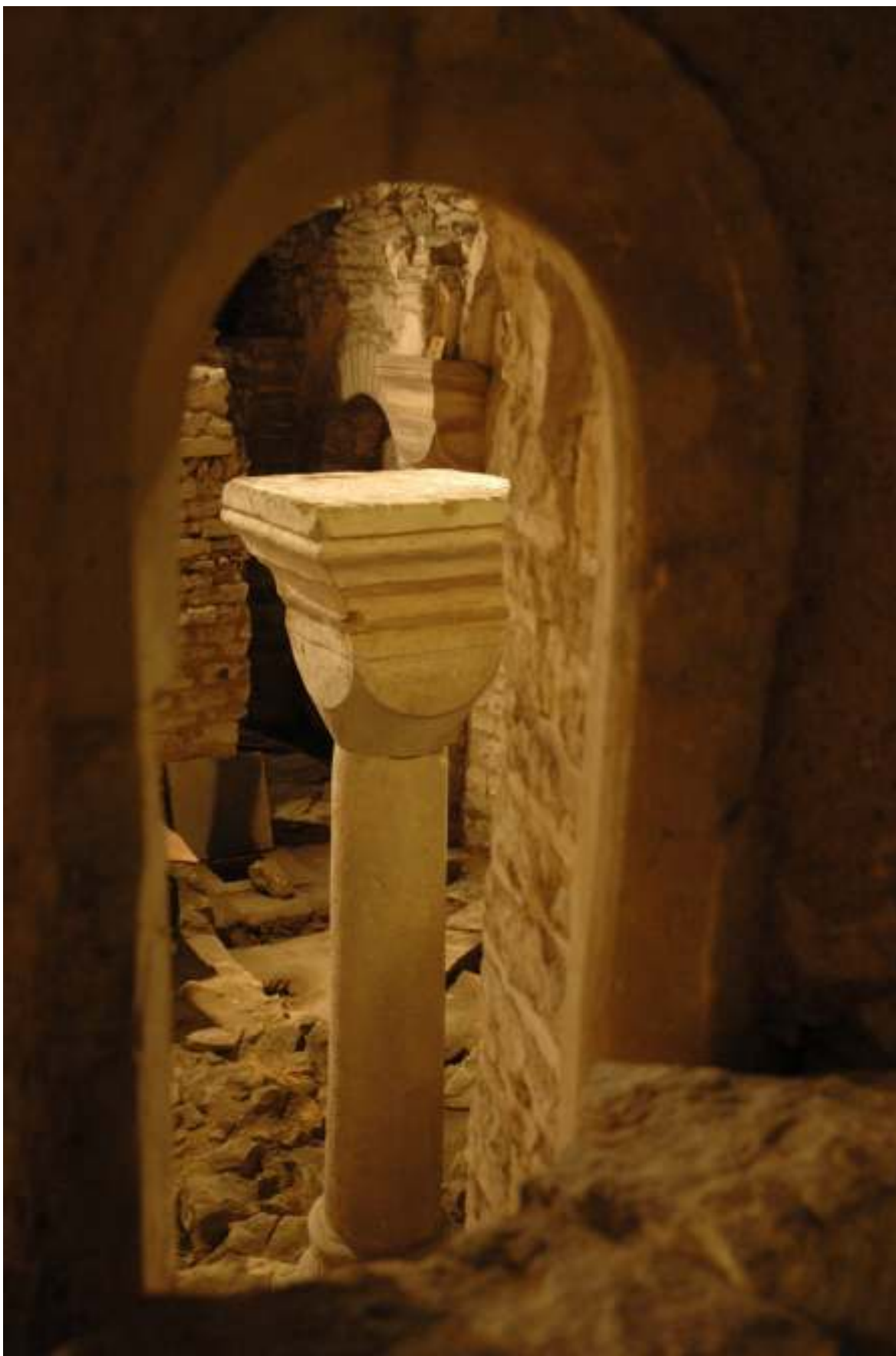
Obrázek 30: Pohled do krypty dochovaným románským oknem. Foto:PL
