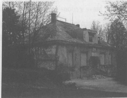
obr. 67: Bývalá Bečvářova vila
