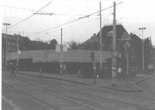
obr. 52: Vestibul stanice Strašnická
