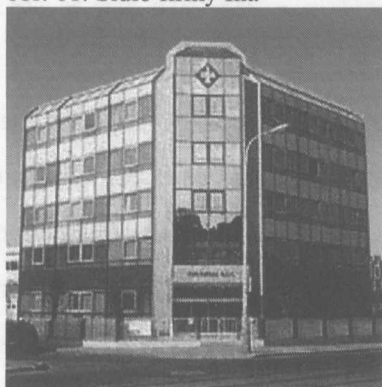
obr. 61: Sídlo firmy Ina
