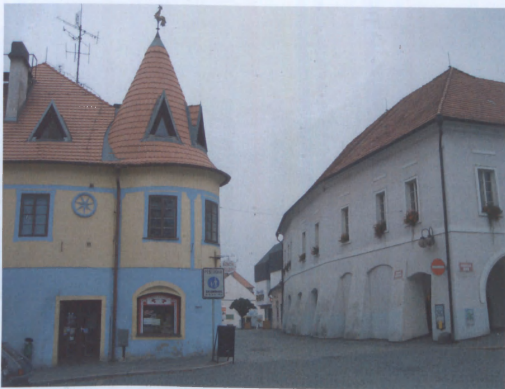
obr. 6 Dům č. 25 a část radnice
