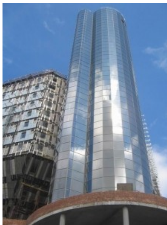
obr. č.11. Běloruská knihovna, vyhlídkový výtah, zdroj http://old.nlb.by/newbuilding/
