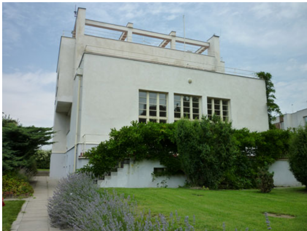
11. Vila Winternitz, Adolf Loos, 1932, Smíchov, Praha 5
