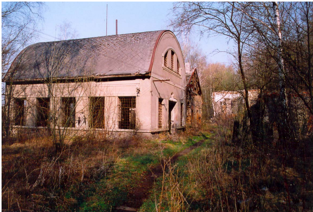
Obr. 1. Opuštěné provozní budovy by měly být po ukončení těžby odstraněny, snižují potenciální přírodovědnou a estetickou hodnotu lomu a lákají k zakládání černých skládek.
