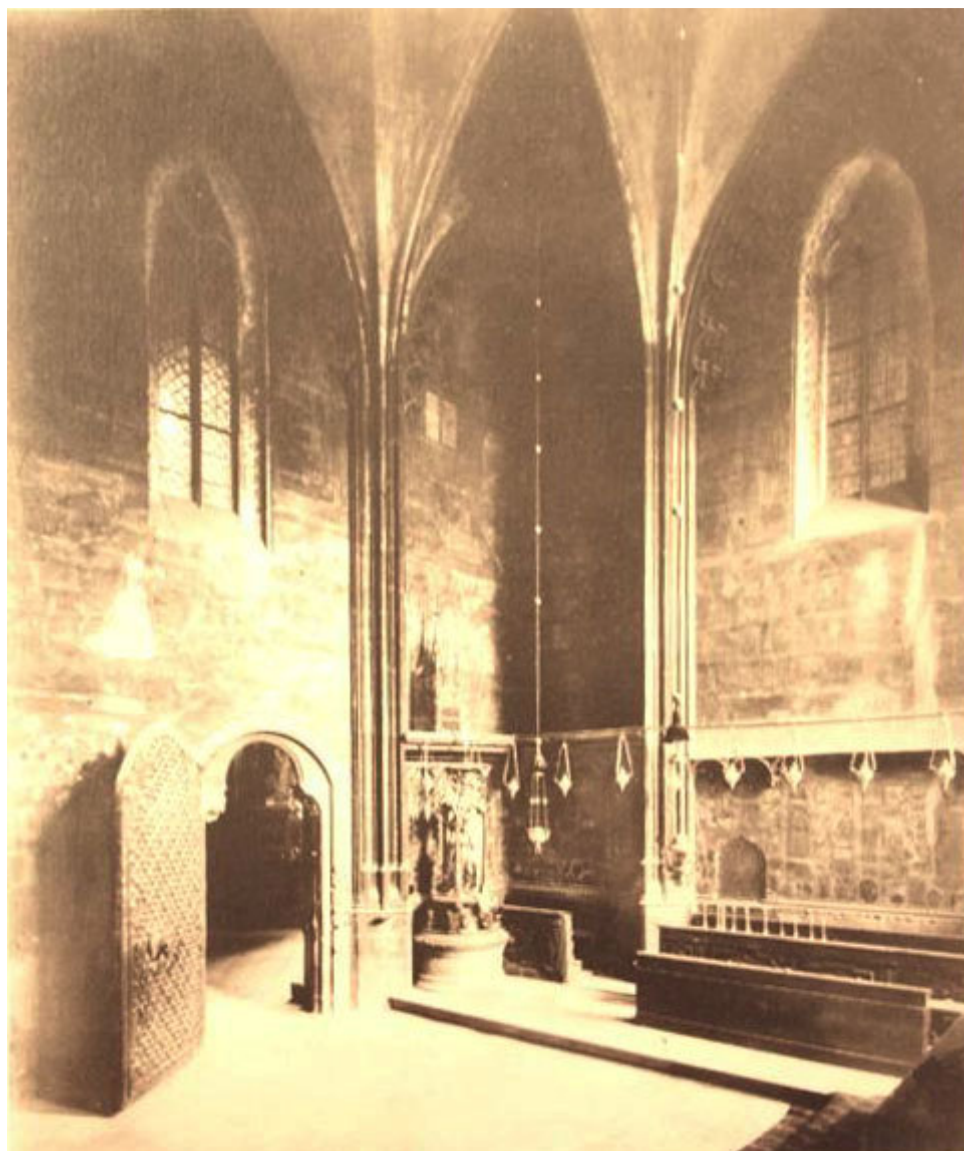
34. Pohled do Svatováclavské kaple od vstupu do Korunní komory, foto Jindřich Eckert, kolem 1890, 28 x 22,5 cm
