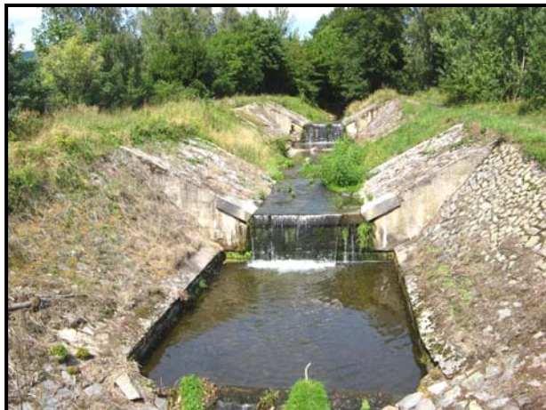
Obr. 37 Narovnáním a vybetonováním koryt vodních toků se urychluje odtok vody z krajiny. Napřímené koryto Oseckého potoka.
