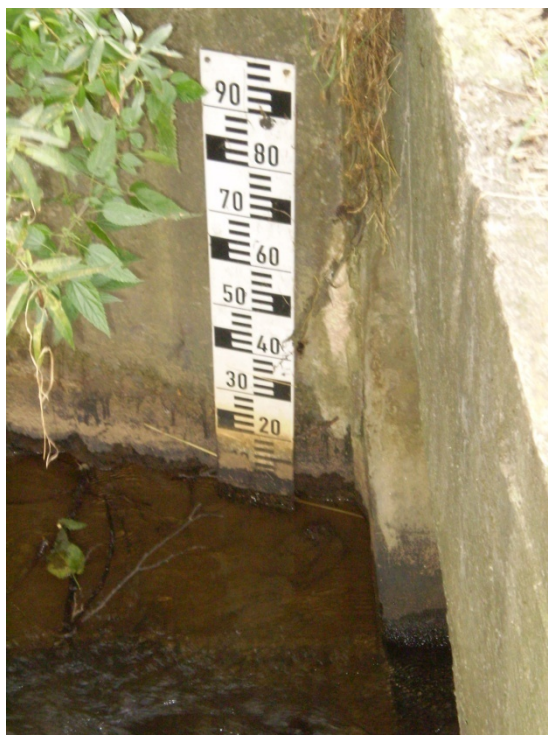
Obr. 85: Vodočet v Přeňově (foto: autor)
