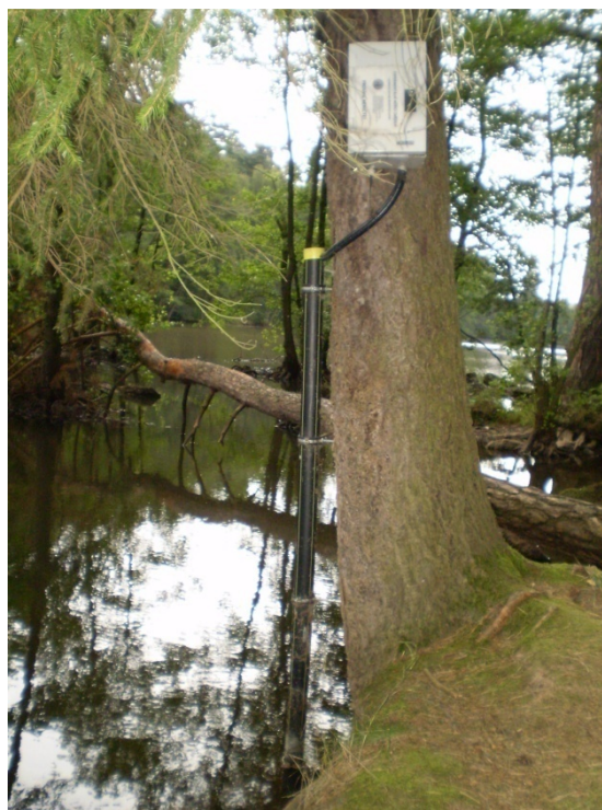
Obr. 91: Hladinoměr na Mladotickém jezeře (foto: autor)
