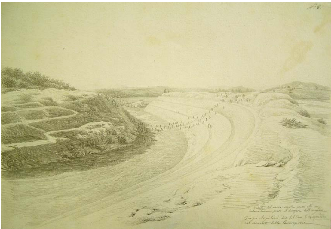
Obr. 29 – Pohled z hráze na Primo Diversivo poblíž vyústění, Angiolini, 1830
