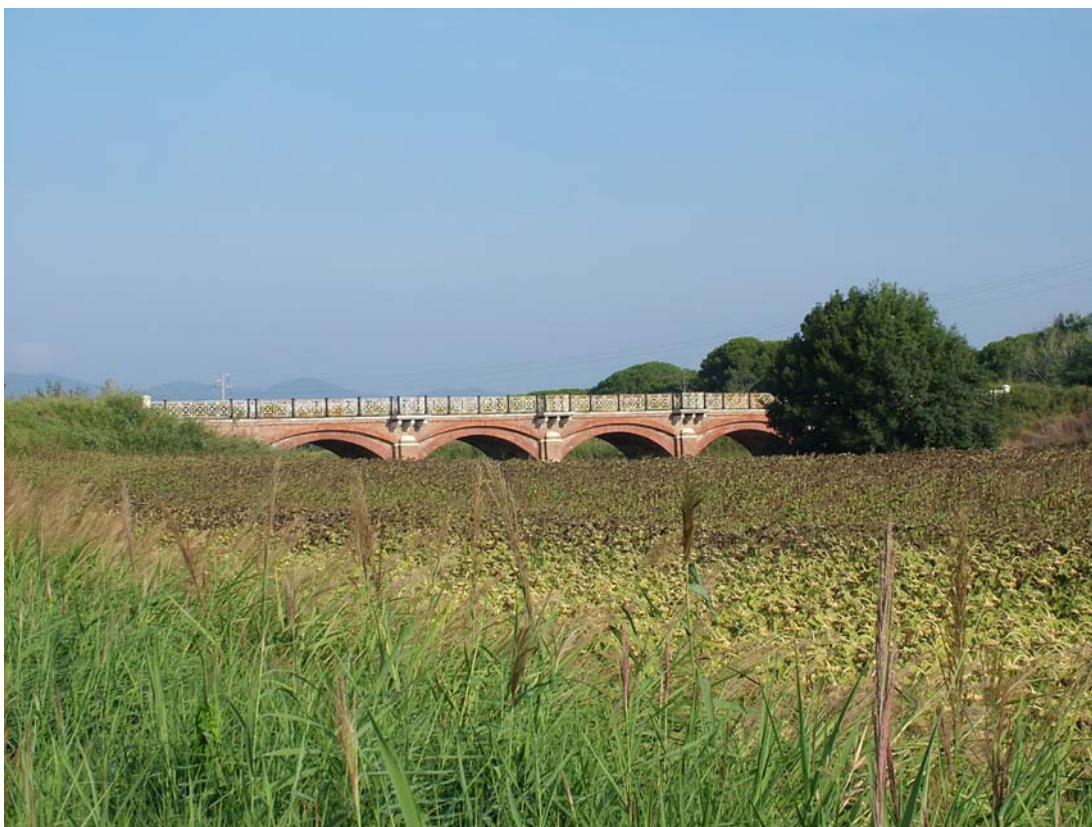
Obr. 34 – Pohled na most přes Secondo Diversivo, 2005
