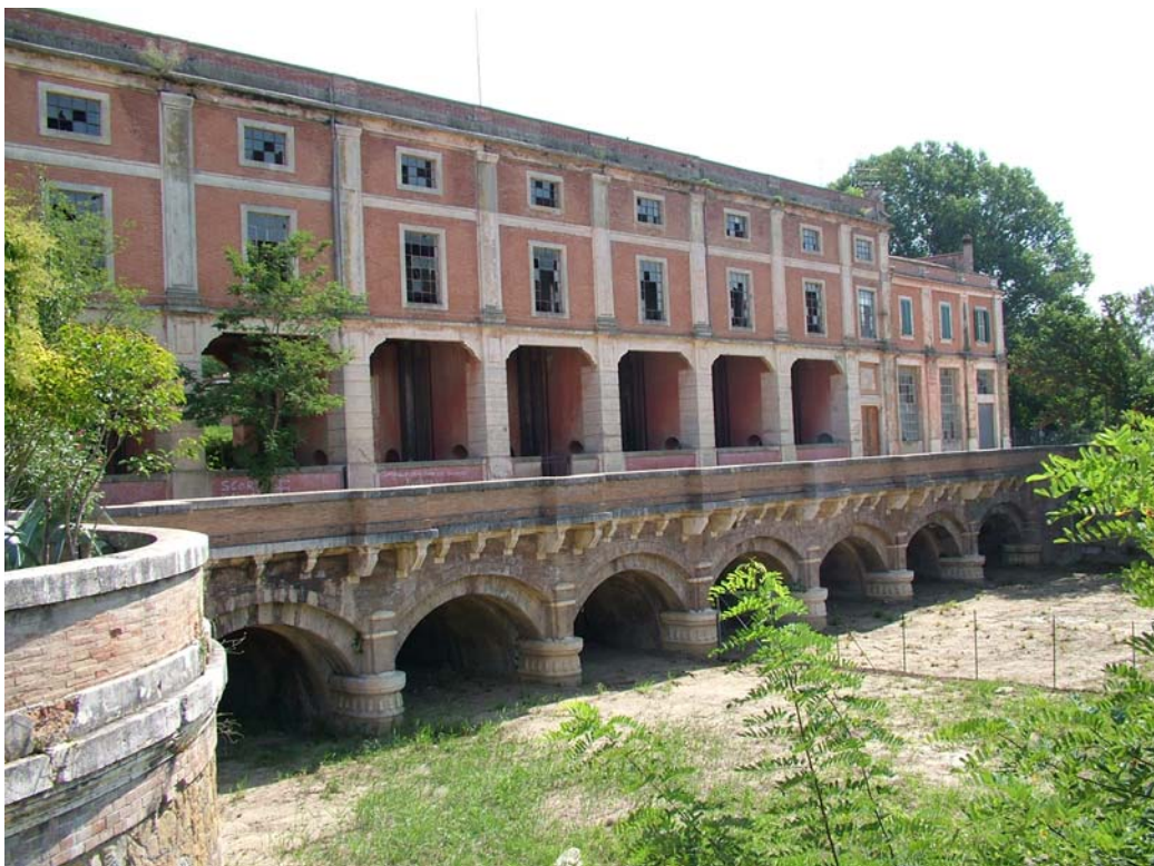
Obr. 28 – Stavidlový objekt zbudovaný na Primo Diversivo, 2005
