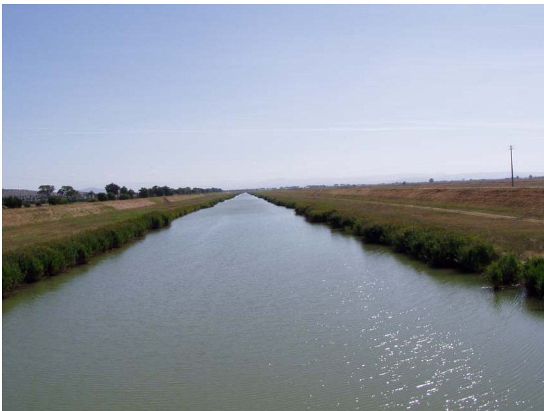
Obr. 39 – Pohled na regulovanou řeku Bruna, 2004
