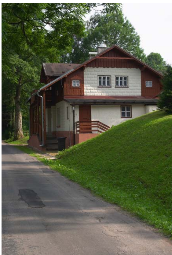
21. Horní Albeřice čp. 59, bývalý obecní dům, foto Jan Faltejsek, 2009
