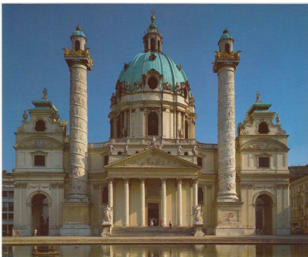
6. Pohled na průčelí chrámu.
