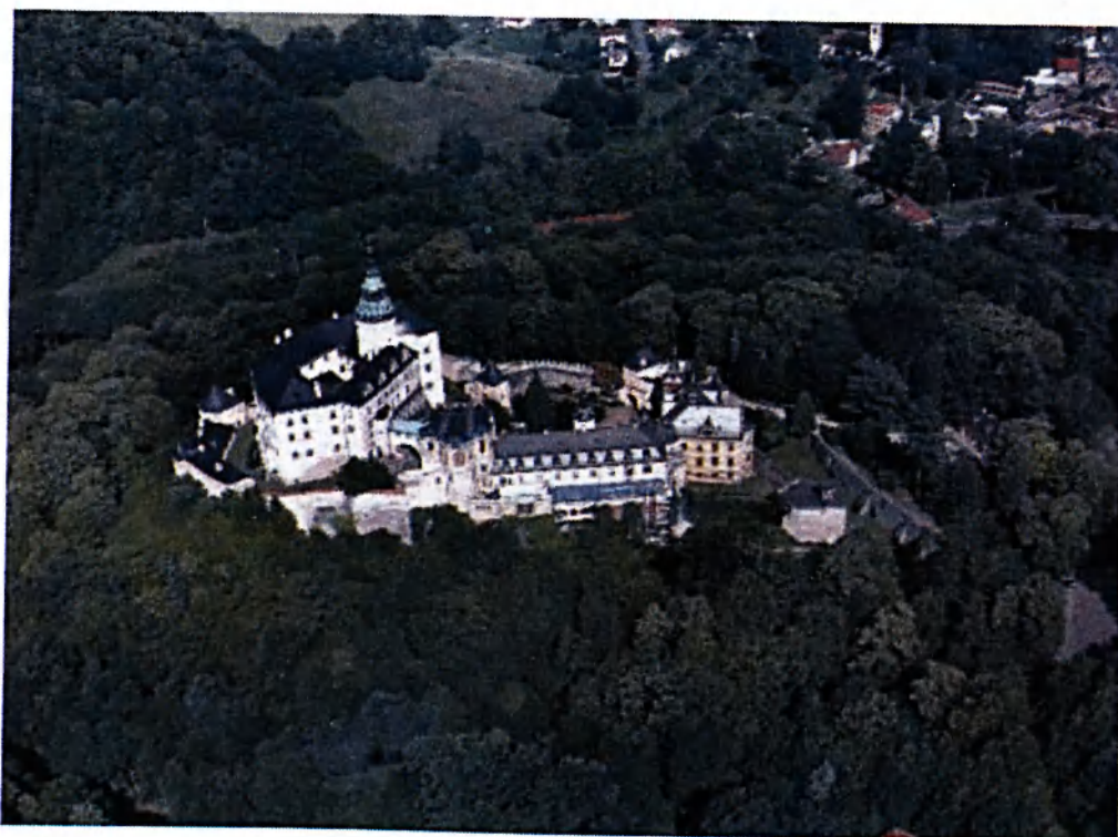
8. Letecký pohled na Frýdlant – ze západní strany
