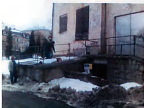
zajištění bezpečnosti okolí budovy....
