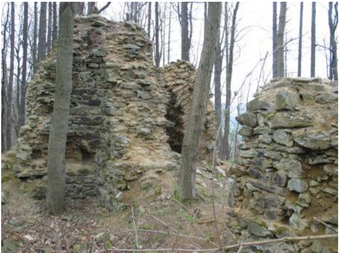
Obr. 46. Pušperk, interiér donjonu
