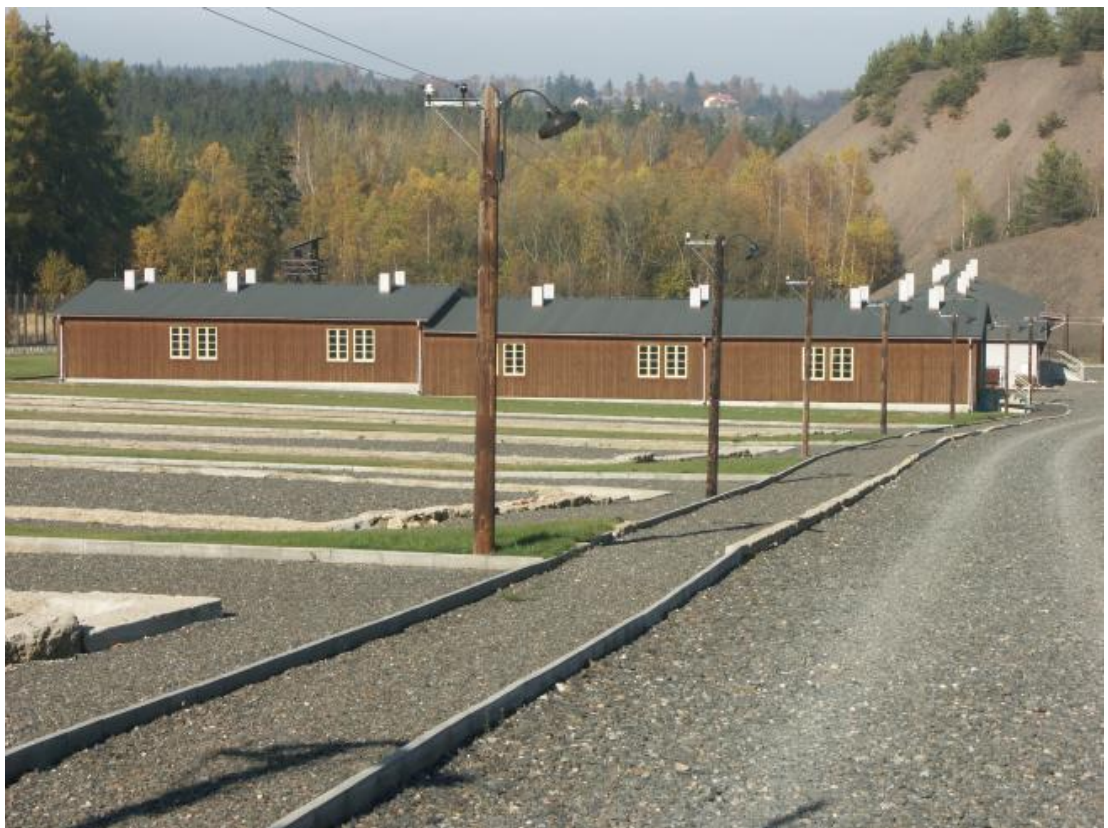
Obr. 6: Ubytovací objekt G
