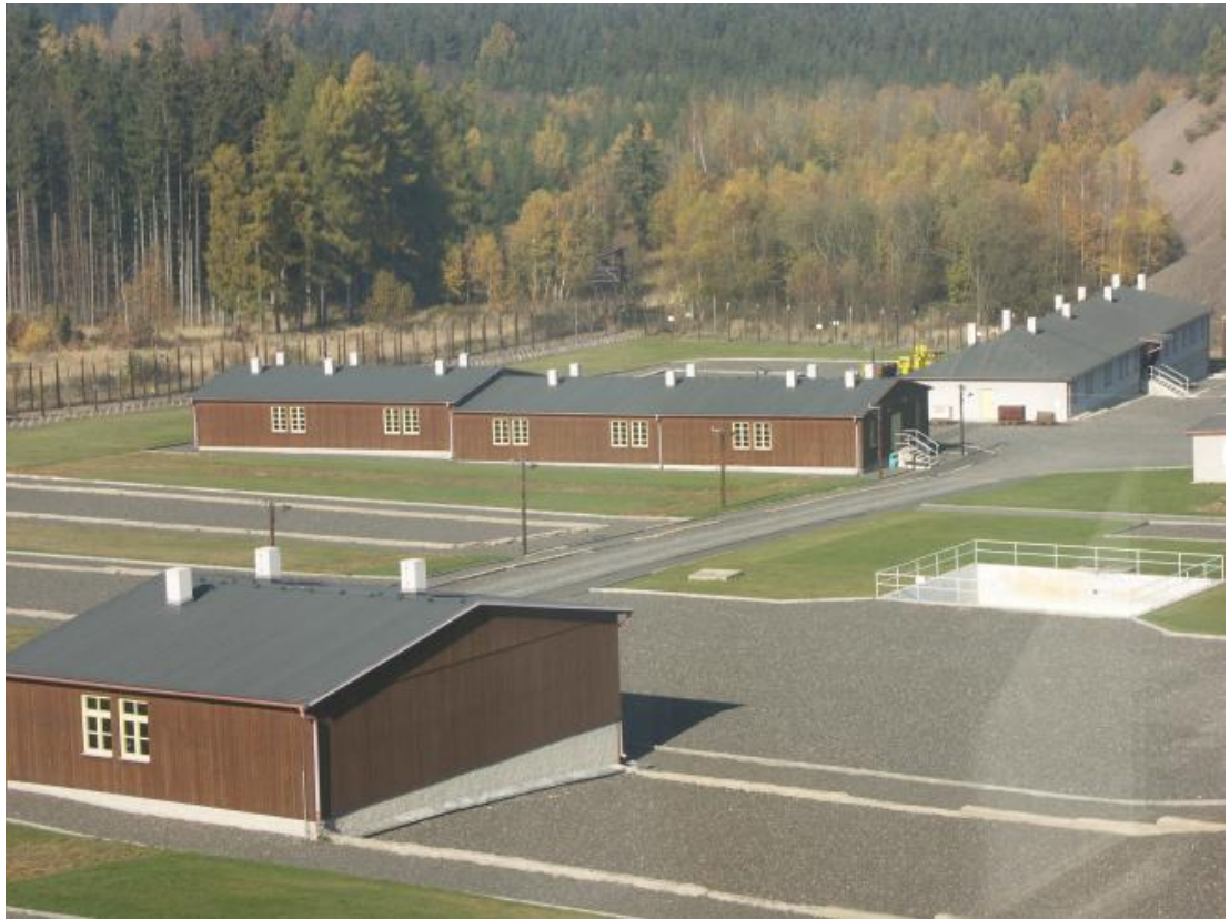
Obr. 5: Kulturní dům (v popředí) a ubytovací objekt G
