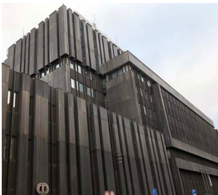
36. Vratislav Růžička, Boris Rákosník, fasáda budovy centrálního dispečinku městské dopravy, Na Bojišti čp. 1452/5, Praha-Nové Město, 1972-1978
