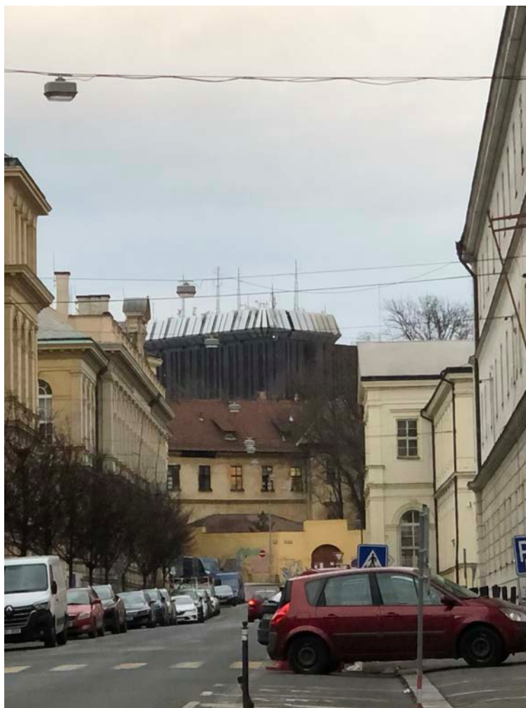
37. Vratislav Růžička, Boris Rákosník, budova centrálního dispečinku městské dopravy, pohled z ulice U Nemocnice, Praha-Nové Město, 1972-1978
