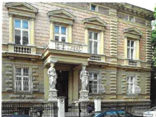
Obr. 16. Fasáda z omítky z přírodního cementu (přízemí, přirozená barva); Vídeň (Weber a kol., 2008)
