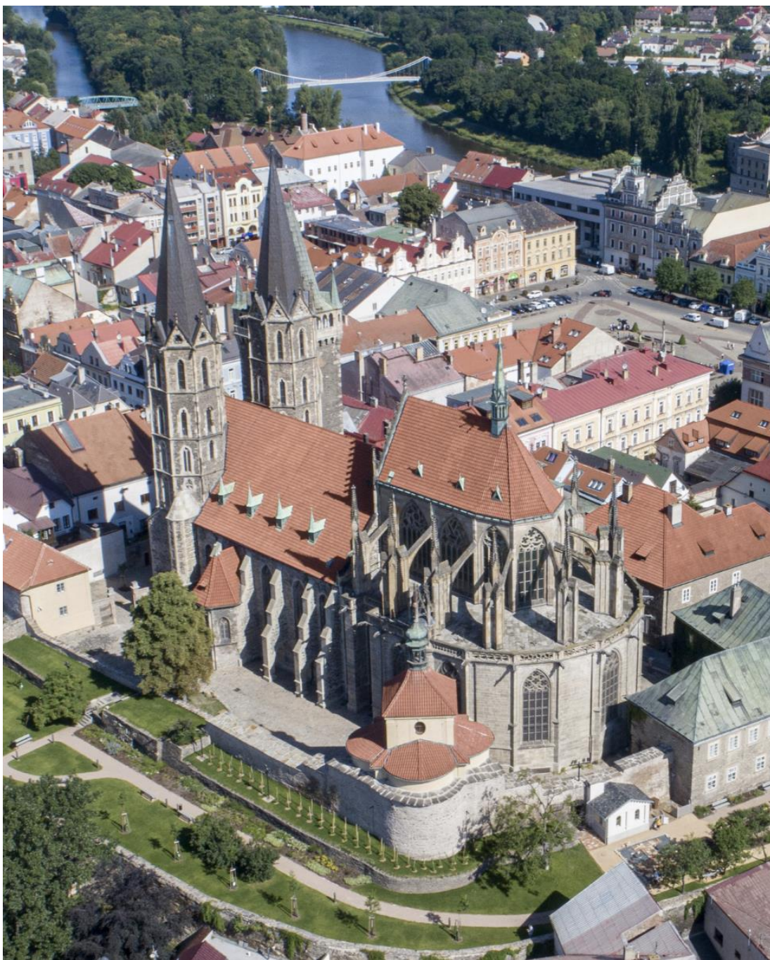
Obrázek III/III-8 – Kolín nad Labem, kostel sv. Bartoloměje, 1360–1378, pohled od jihovýchodu
