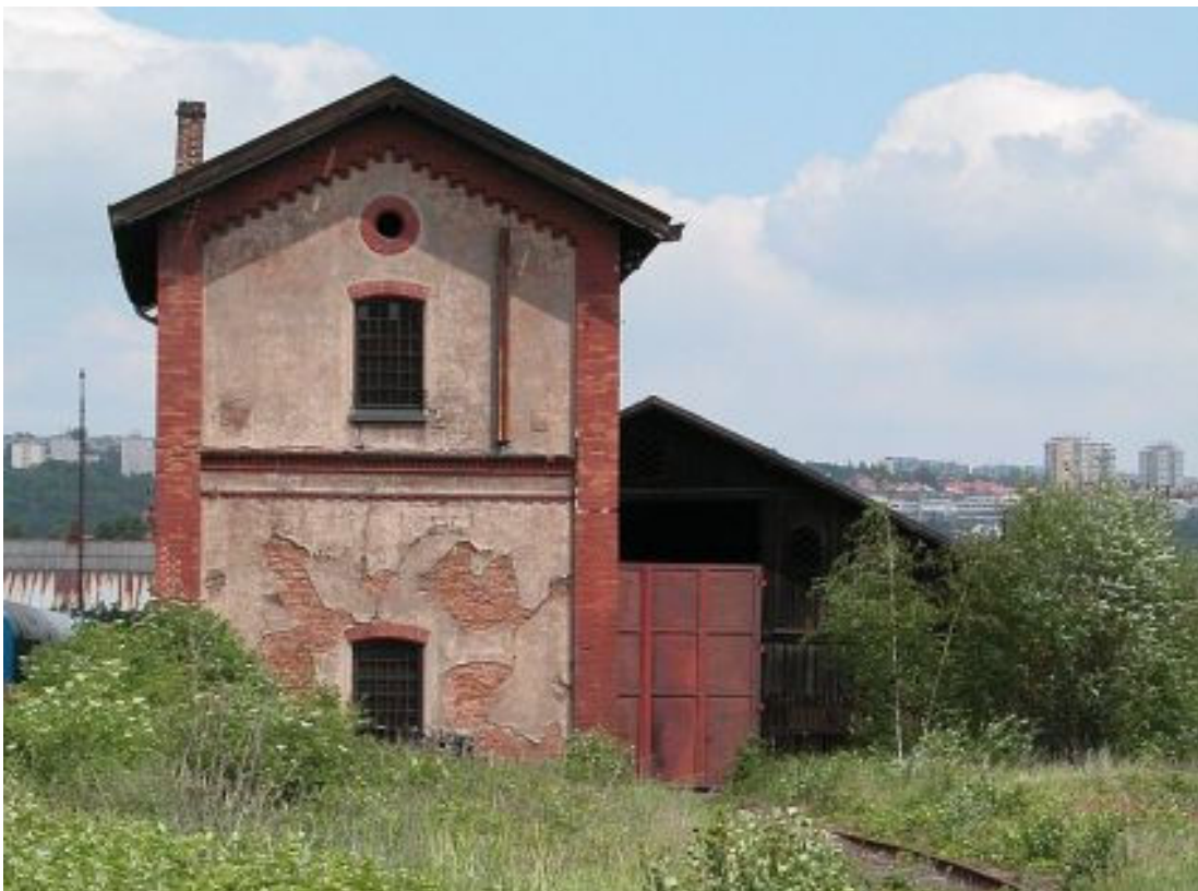
Fotografie č. 22: Železniční areál Holešovice-Bubny, vodárna, 2004
