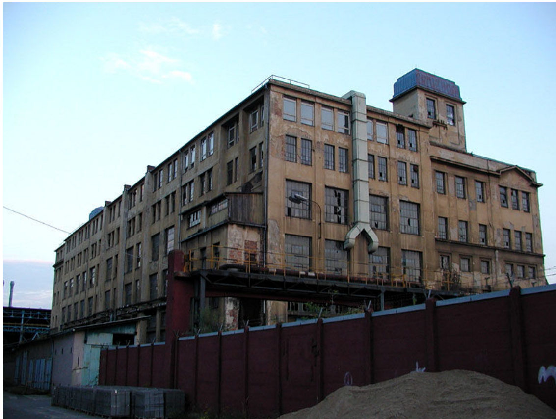
Fotografie č. 4: Pragovka stav před demolicí, západní pohled
