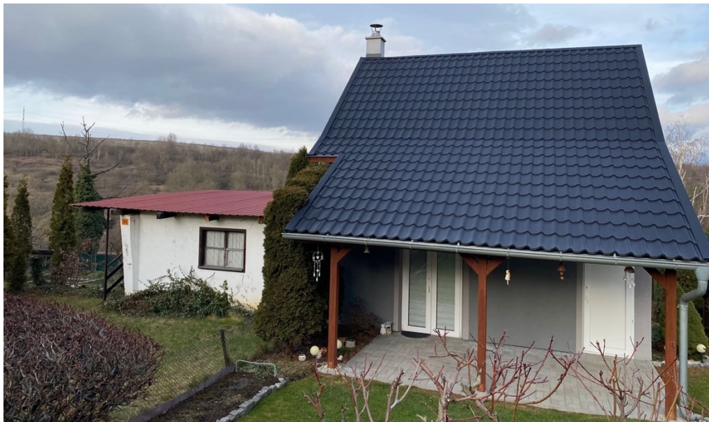
Obrázek 25: Chata č.p. 45 a objekt č. p. 156
