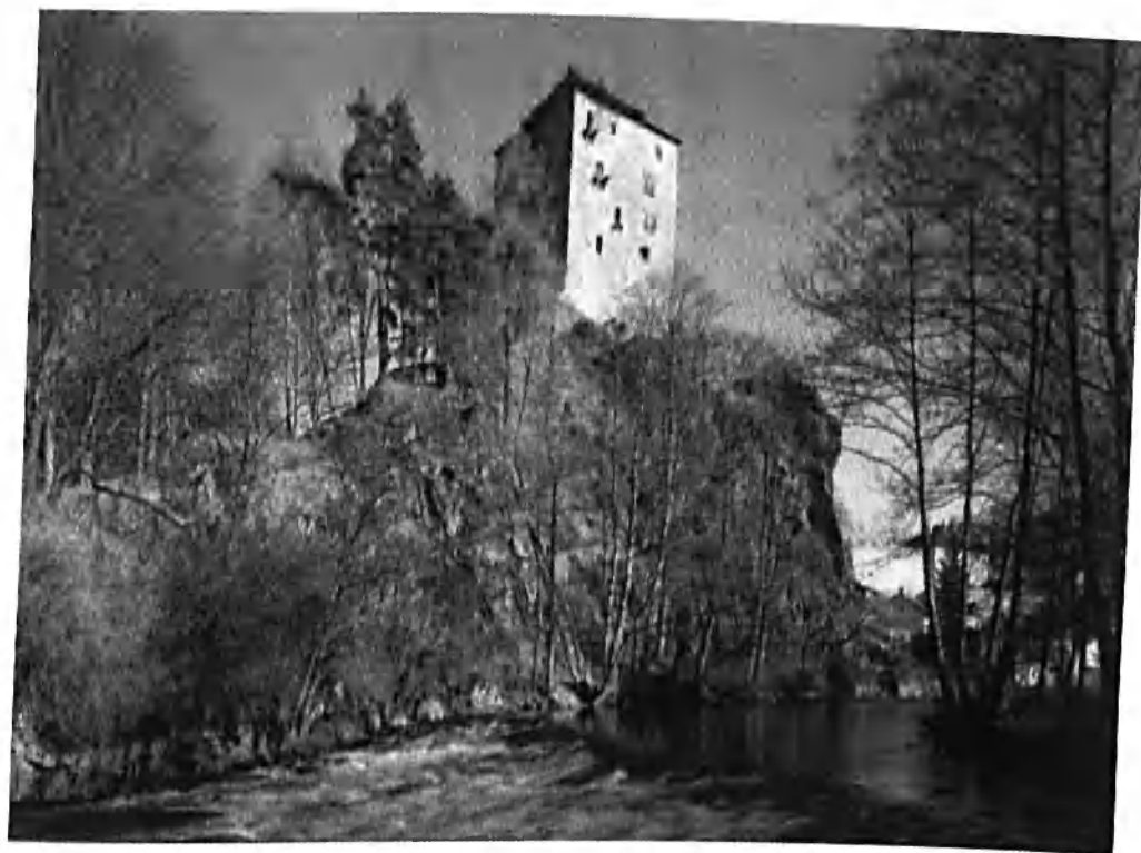
Obr.č.17. Hrad Bečov nad Teplou
