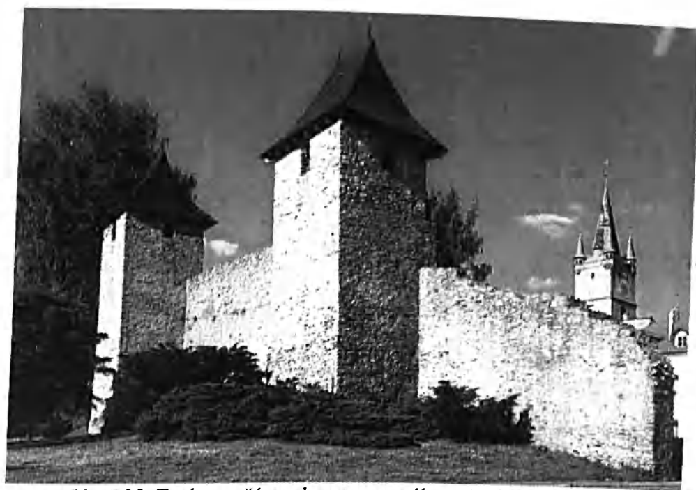
Obr.č.25. Tachov – část rekonstruovaného městského opevnění
