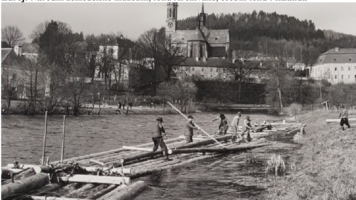
Obrázek 18 Stavba 4 vorového pramene na Vltavě v roce 1966. Nakládání nákladu na vor. Zdroj: Národní zemědělské muzeum, fond Archiválie, osobní fond M.Landa
