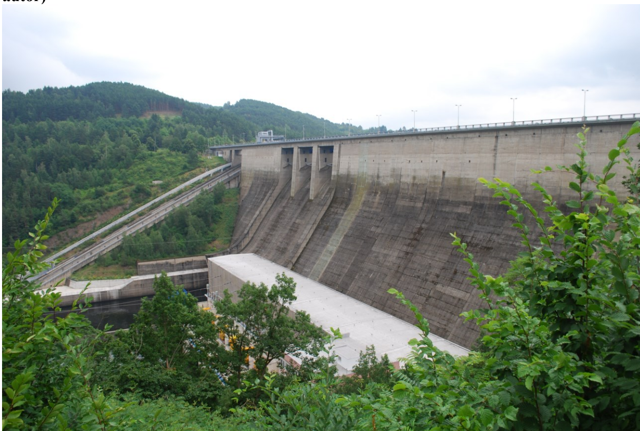
Obrázek 16 Hráz vodního díla Orlik, vybudovaného v letech 1954-1962 na Vltavě poblíž osad Orlické a Zbenické Zlátkovice (foto: autor)
