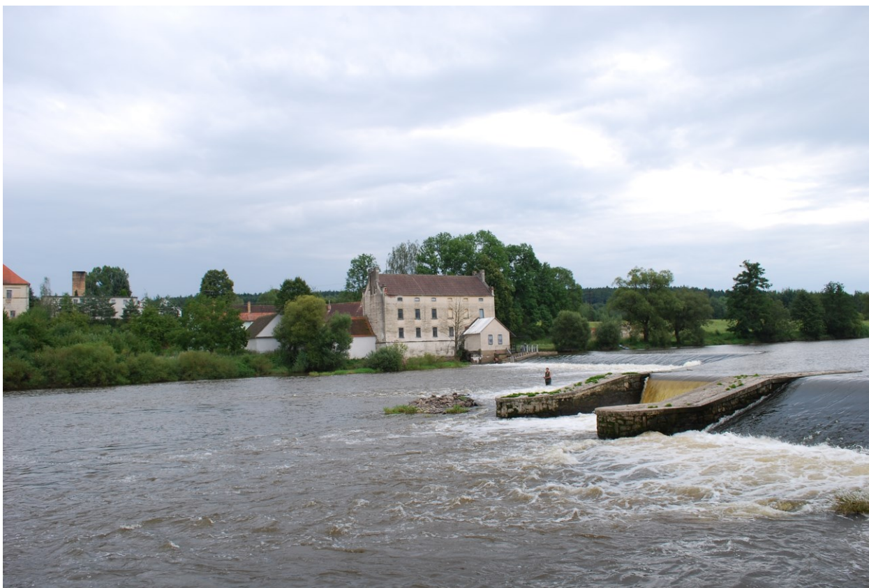
Obrázek 25 Vltava v Hněvkovicích. Na snímku je zachycen jez s vorovou propustí, na jejímž místě byla vybudována po roce 2015 plavební komora, v rámci zajištění splavnosti Vltavy pro menší plavidla v úseku mezi Týnem nad Vltavou a Českými Budějovicemi. Na snímku je rovněž zachycen sportovní rybář. V pozadí Královcův mlýn s elektrárnou. (foto: autor)
