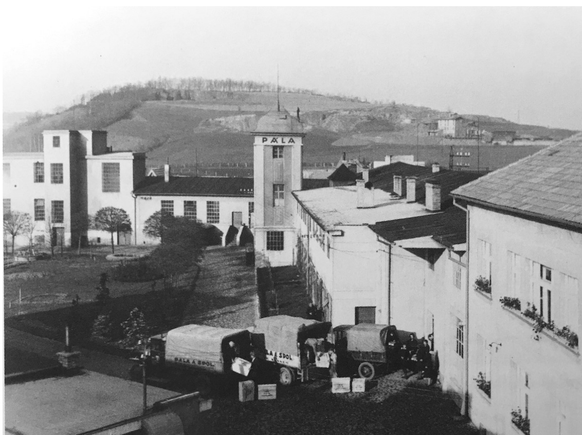
119. PALABA, moderní objekty továrny vystavěl Vilibald Hiecke 1925–1926
