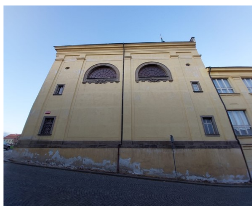
33. Termální okna piaristické kaple
