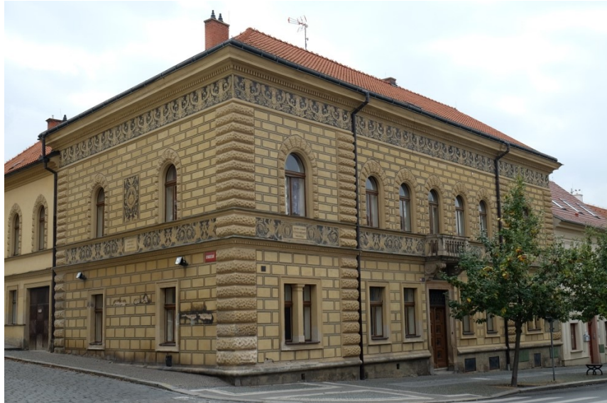
57. Wiehlův dům, Wilsonova ulice
