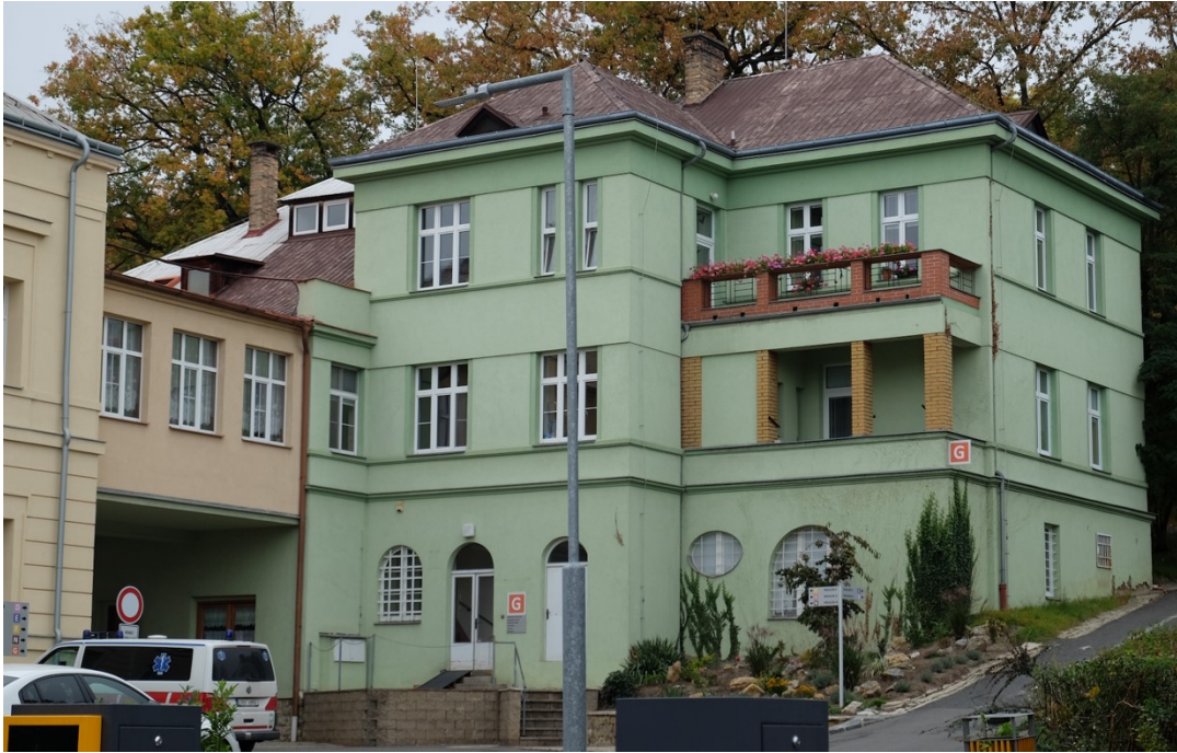
80. Provozní budova v areálu nemocnice
