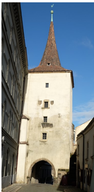
12. Velvarská brána, současný stav
