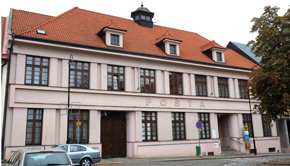
79. Budova pošty, pohled z náměstí TGM, Slaný
