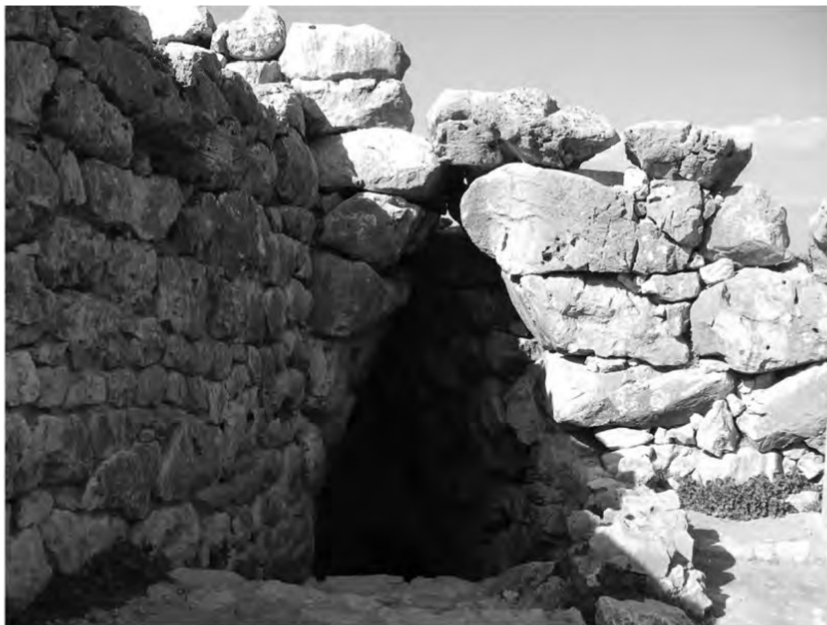
Obrázek 44: Ogivální nepravá klenba bez klenáku, Mykény (podle Maner 2012, Fig. 2).
