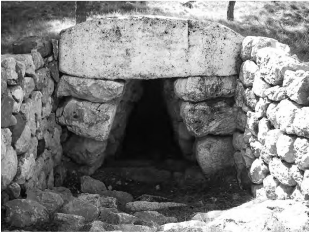
Obrázek 45: Falešná klenba z kvádříkového zdiva v Boğazköy, vstup do tzv. Jarní svatyně (podle Maner 2012, Fig. 6).
