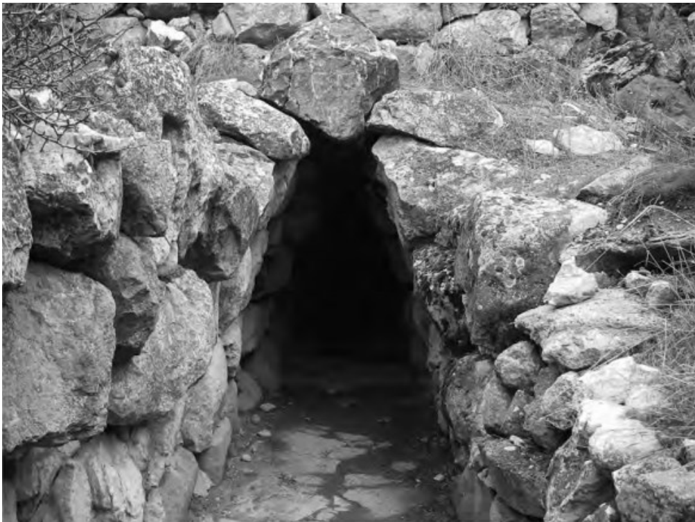
Obrázek 46: Falešná klenba s klenákem v Alaca Höyük (podle Maner 2012, Fig. 3).
