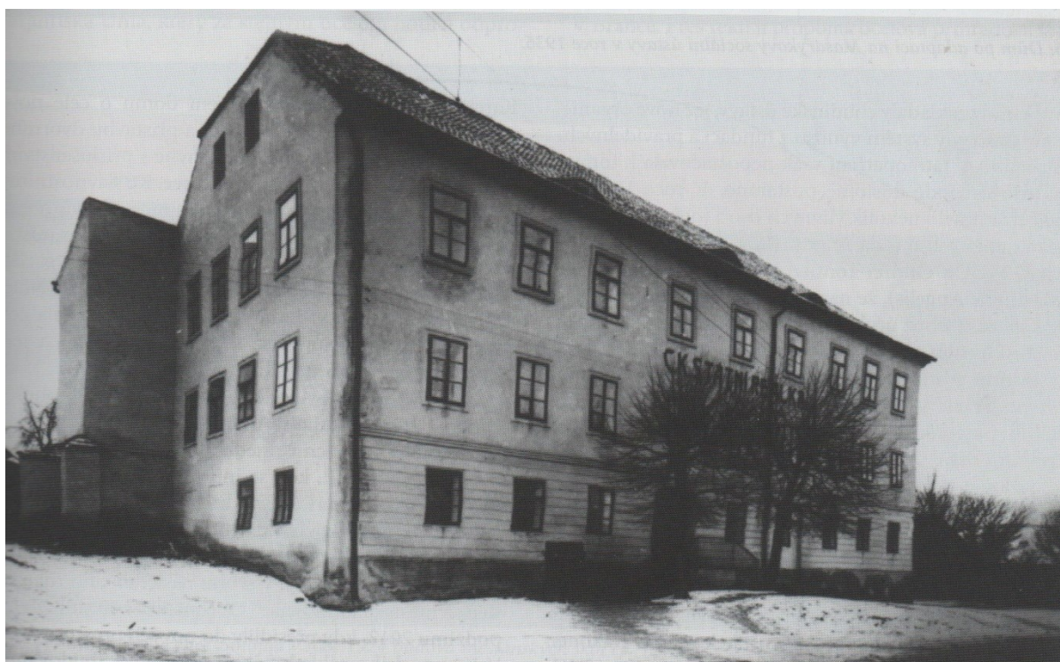
F 2. Tatáž budova po přístavbě patra.
