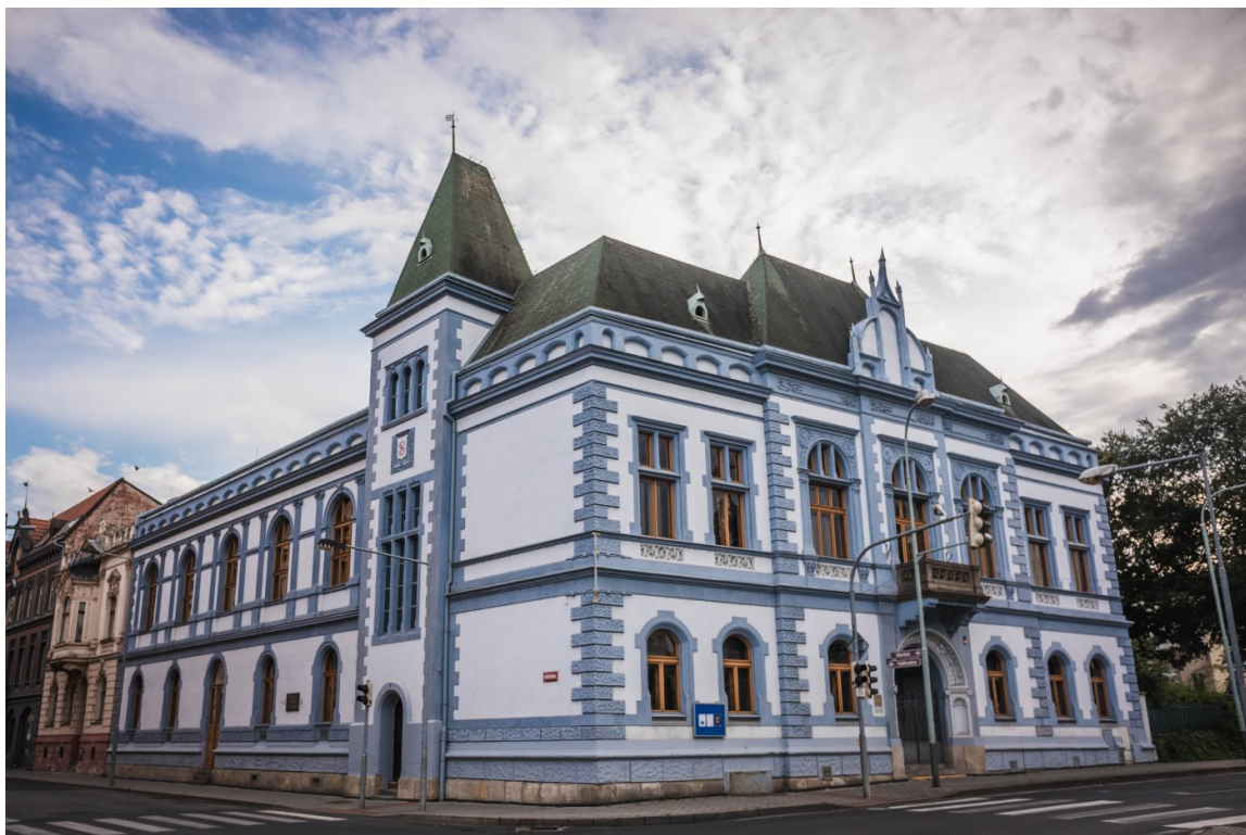
Obrázek 2 Sokolovna v Lounech (postavena 1898)
