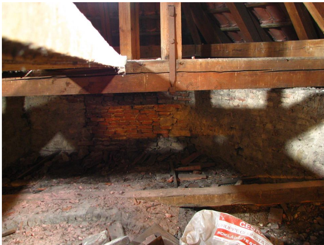
29. Pohled do prostoru nad zaklenutým prostorem presbytáře kostela sv. Pankráce.
