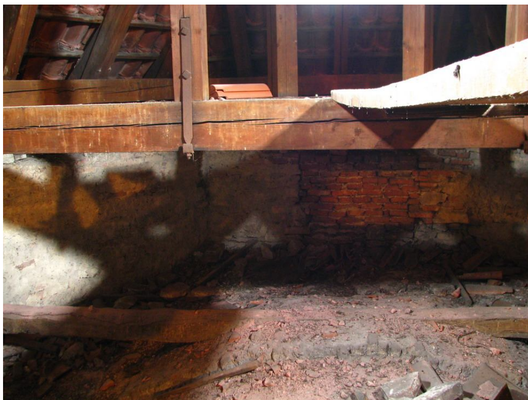
30. Pohled do prostoru nad zaklenutým prostorem presbytáře kostela sv. Pankráce.
