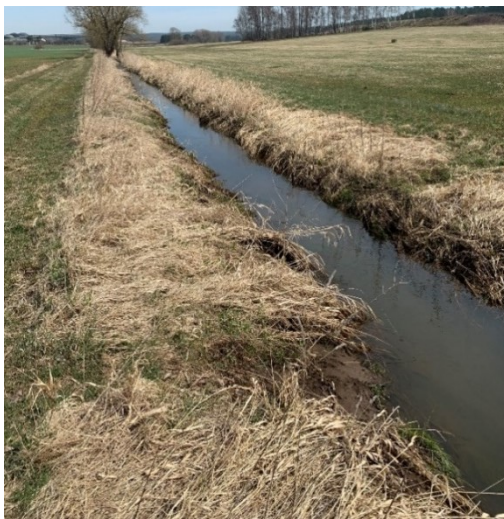
Obr. 20: Napřimený úsek Mladotického potoka (foto autor)
