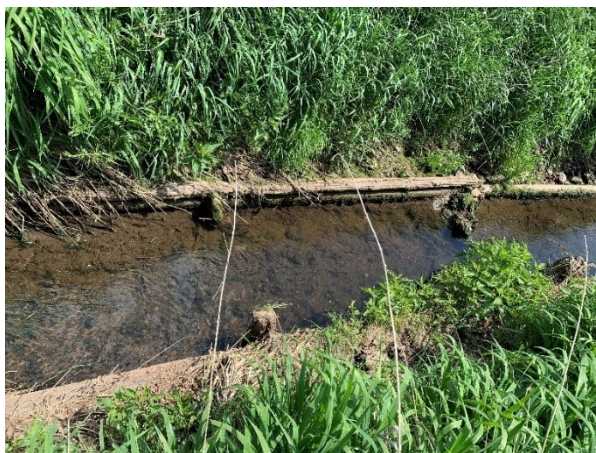
Obr. 31: Vegetační opevnění střední části Mladotického potoka (foto autor)
